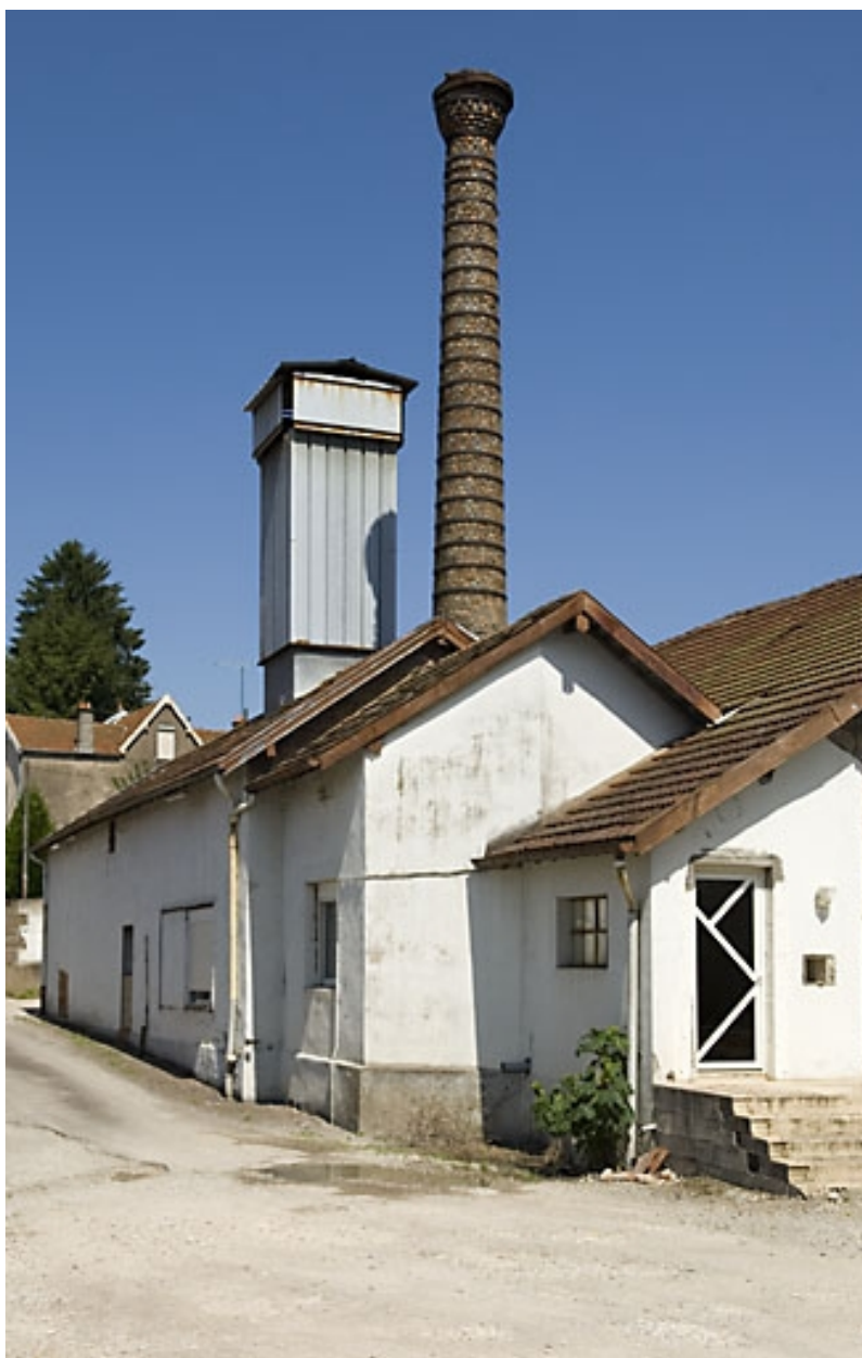
Atelier de fabrication et cheminées.
