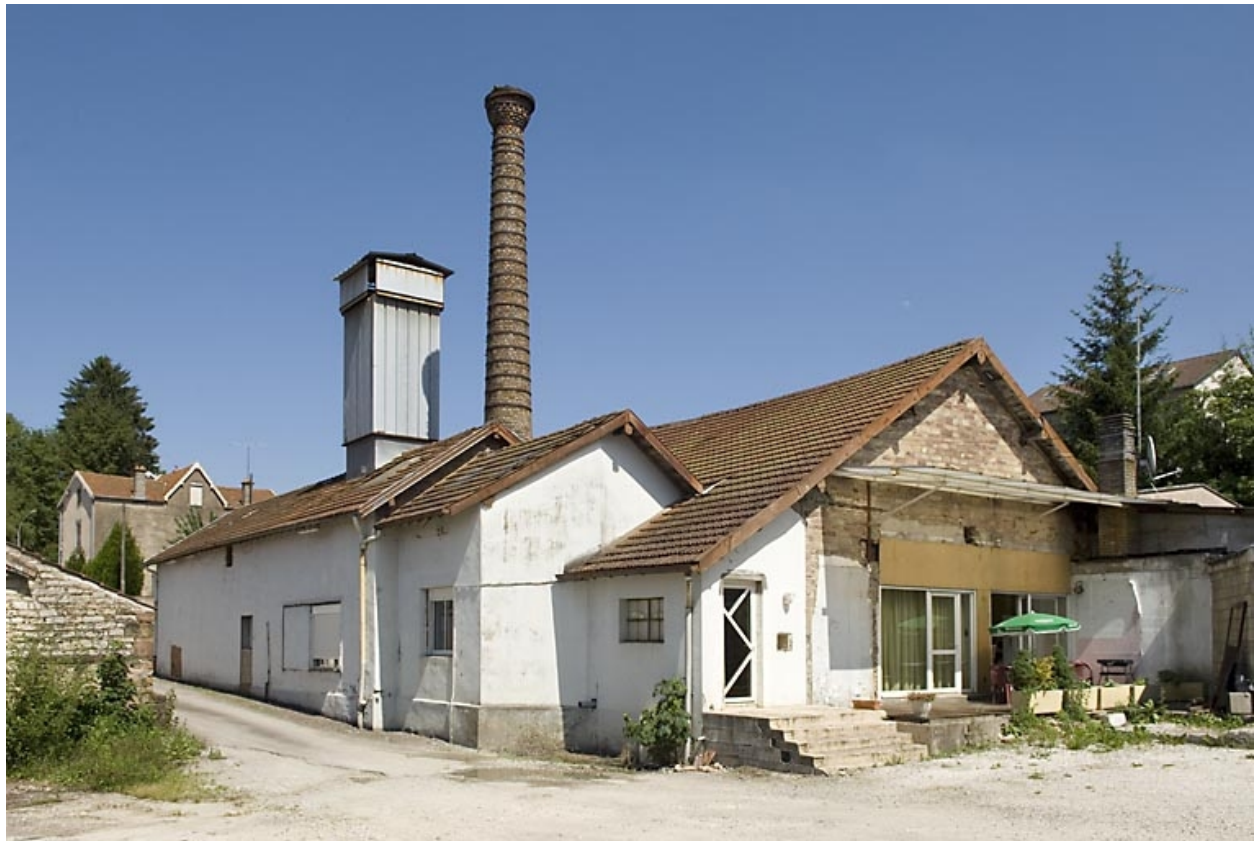
Vue depuis l'ouest.
