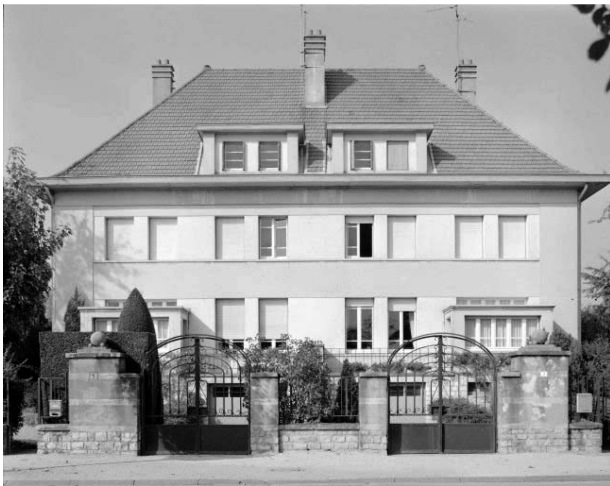
Maison identique, 5, 7 avenue Clémenceau.
