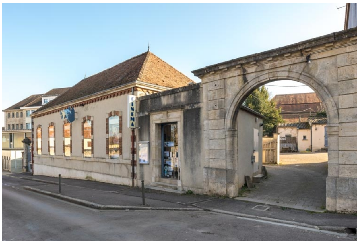
Vue d'ensemble, depuis le sud.
