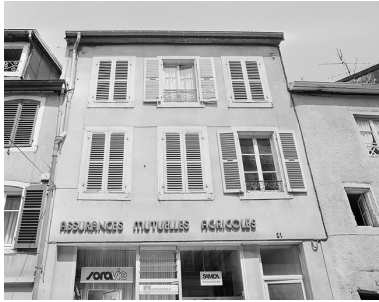
Façade sur rue. Phot. Jérôme Mongreville IVR43_19872500936X
