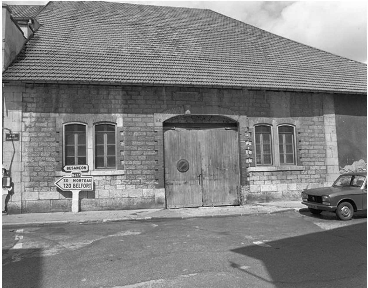
Façade sur rue, vue de face.
