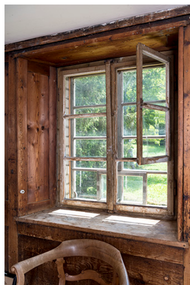
Fenêtre avec deux vitrages. Phot. Sonia Dourlot IVR43_20172500781NUC4A
