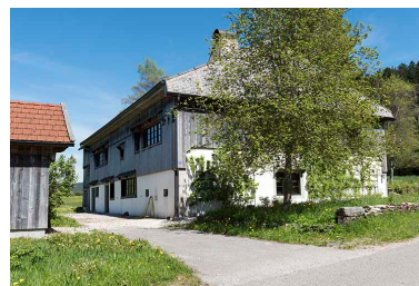
Façades nord et ouest. Phot. Sonia Dourlot IVR43_20172500776NUC4A
