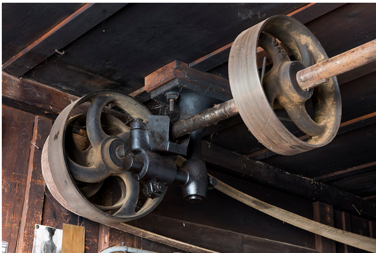
Atelier : transmission au plafond.
