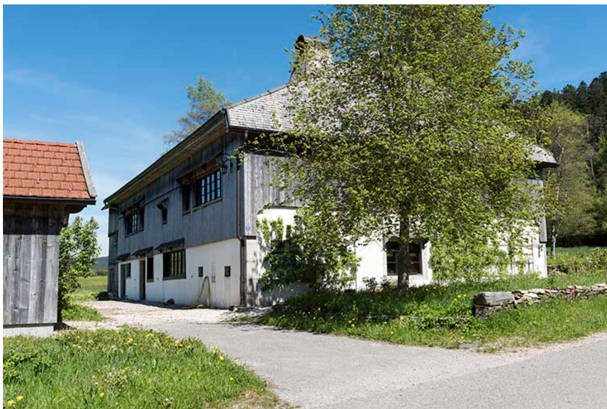
Façades nord et ouest.
