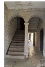
escalier dans oeuvre.
