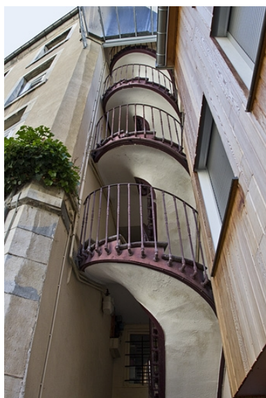
Logis secondaire gauche : détail de l'escalier à cage ouverte à l'extrémité du bâtiment.
