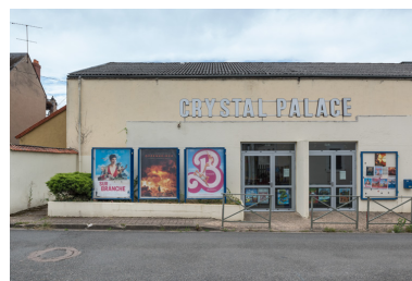
Façade antérieure : entrée. Phot. Pierre-Marie Barbe-Richaud IVR26_20235800215NUC4A
