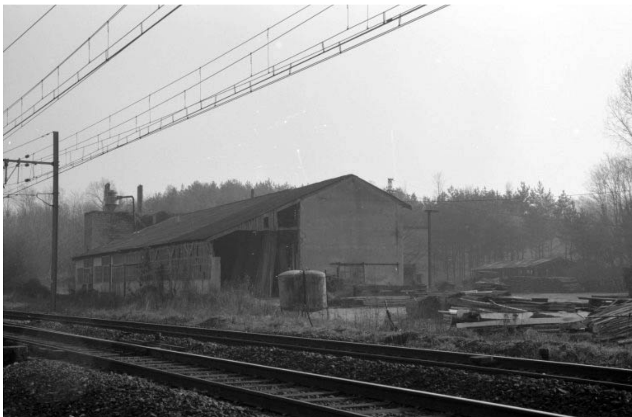
Menuiserie (M), depuis le nord-est.
