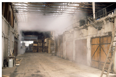
Les étuves. Phot. Laurent Poupard IVR43_19893900278ZA
