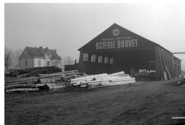
Atelier des scies. Phot. Laurent Poupard IVR43_19893900276Z
