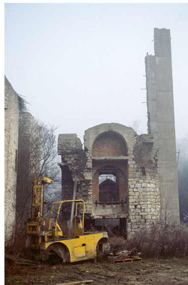
Vestiges du four à chaux. Phot. Laurent Poupard IVR43_19893900283ZA
