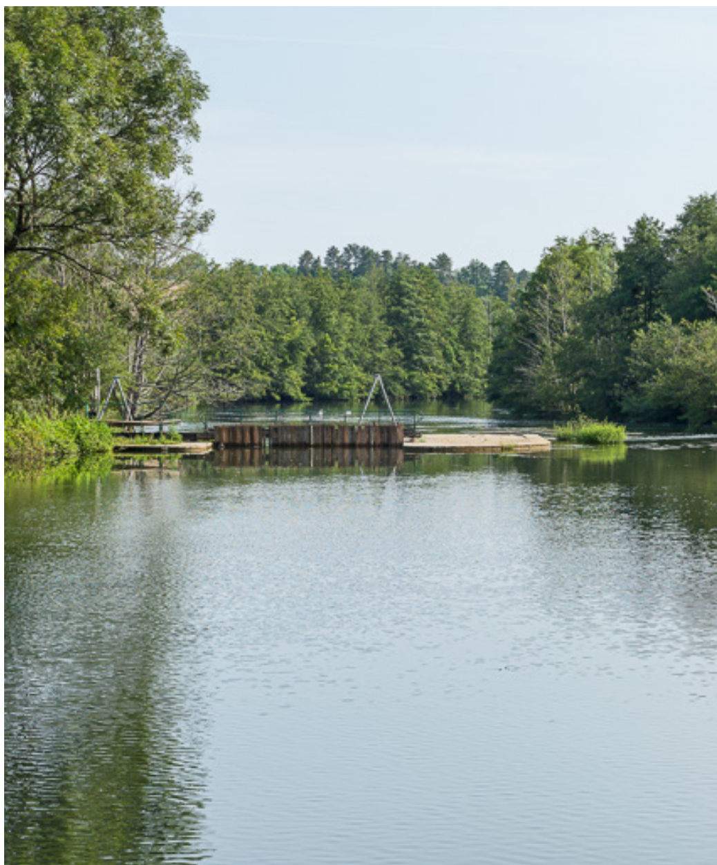
Vue d'ensemble du barrage à aiguilles.
