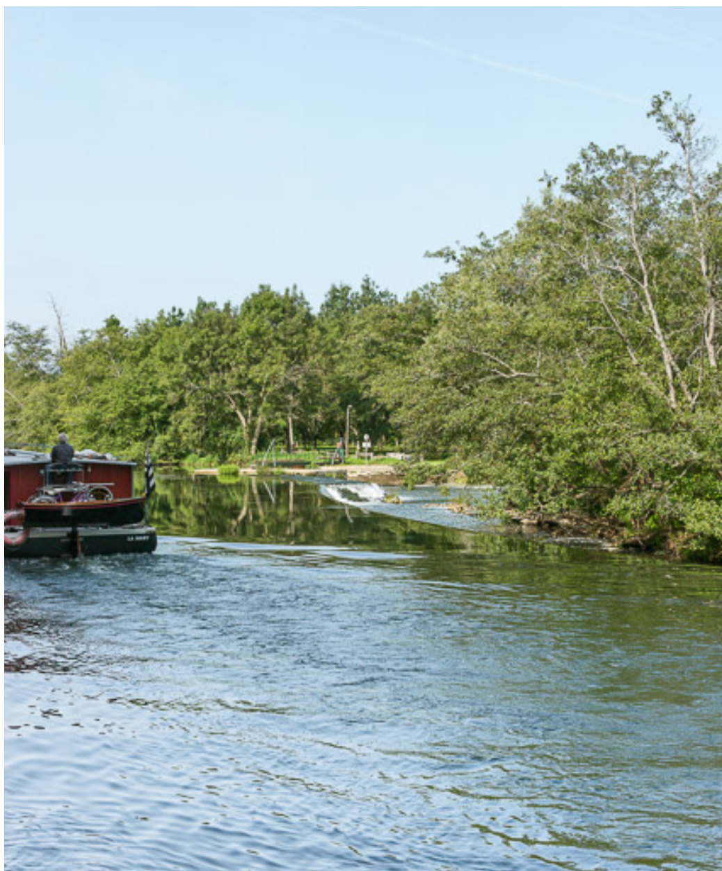
Vue du barrage à aiguilles.
