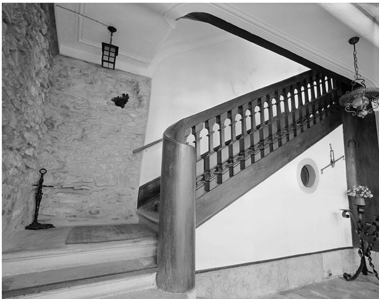
Escalier principal vu du rez-de-chaussée.
