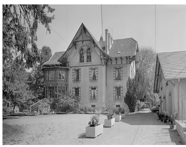
Logement patronal depuis l'ouest. Phot. Jérôme Mongreville IVR43_19973900270V
