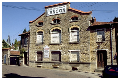
Façade antérieure. Phot. Jérôme Mongreville IVR43_19973900276ZA
