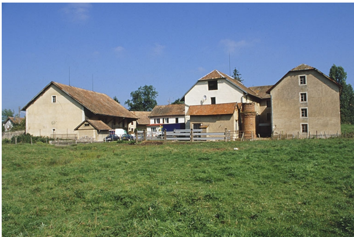
Vue d'ensemble depuis l'ouest.
