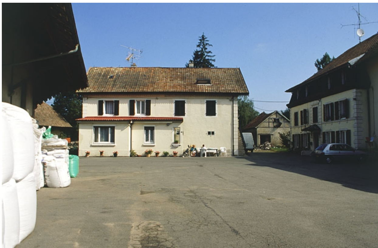
Logements depuis la cour.
