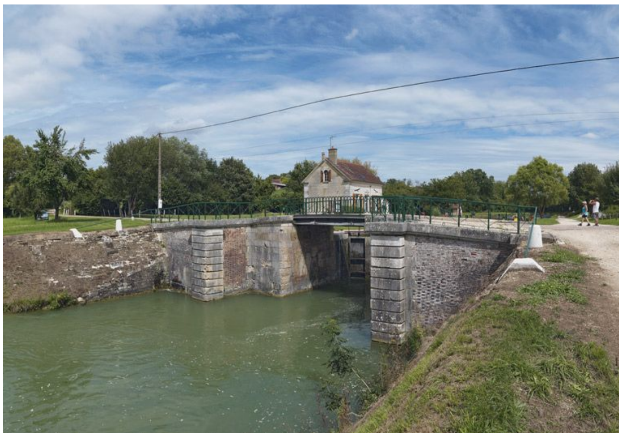
Vue d'ensemble, prise d'aval.
