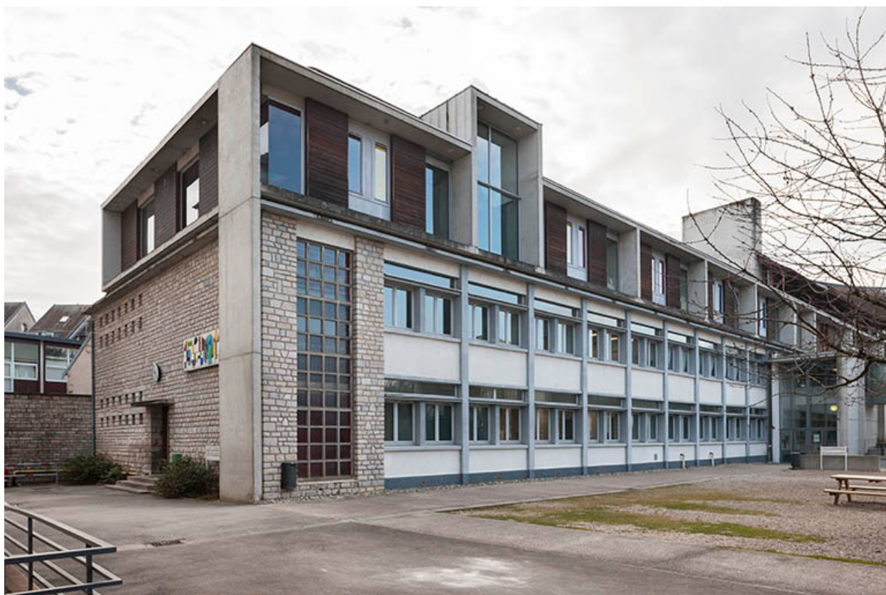
Angle nord-ouest de l'externat.
