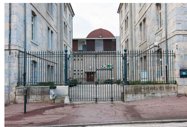
Grille d'entrée donnant sur la place. Phot. Jérôme Mongreville IVR43_20152500064NUC4A
