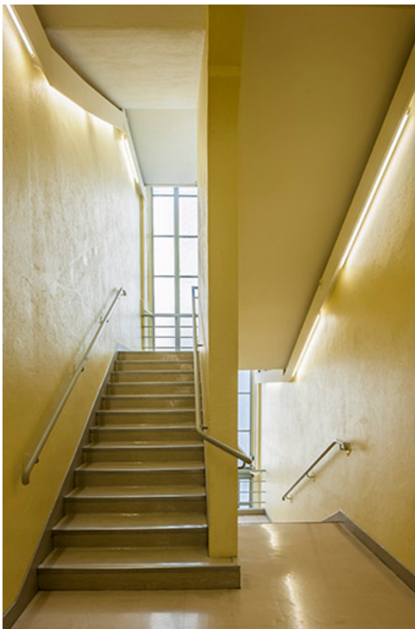
Détail d'escalier dans le pavillon d'officier est.
