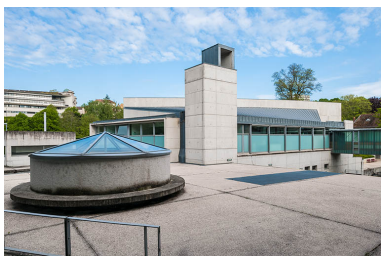
Angle sud-est du restaurant d'application.
