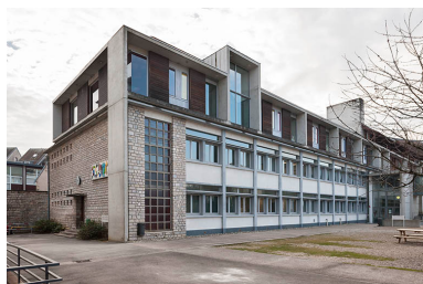
Angle nord-ouest de l'externat.
