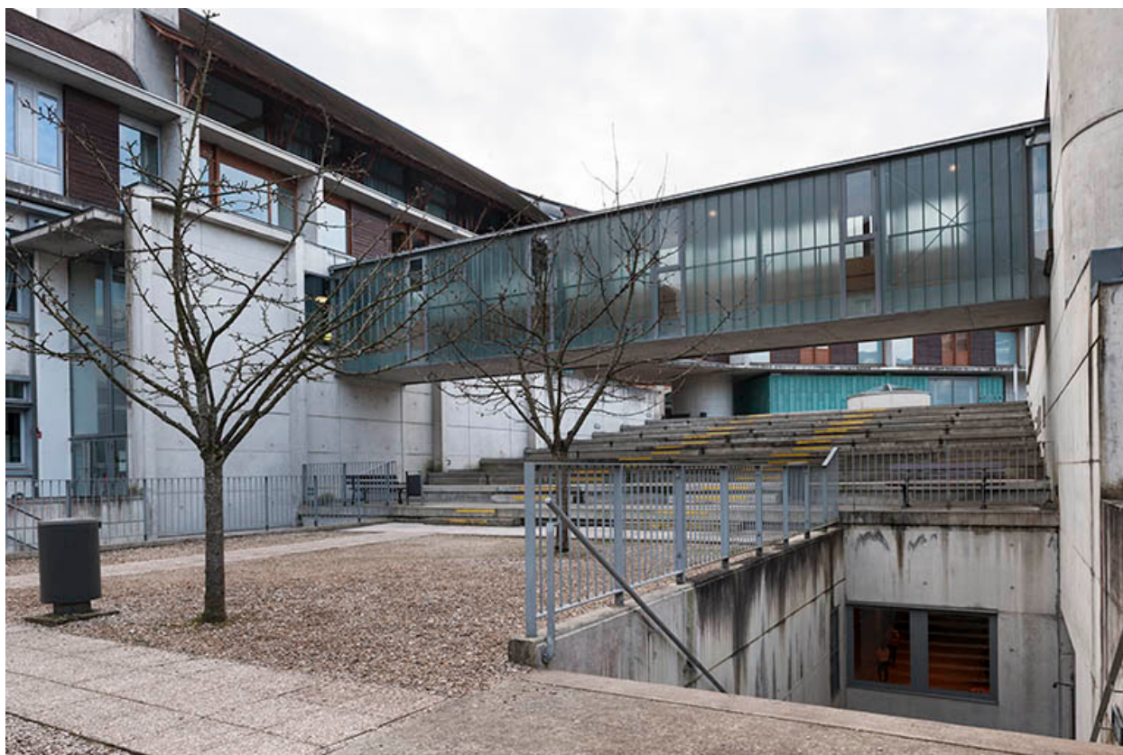
L'entrée du gymnase dans la cour.
