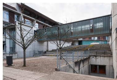
L'entrée du gymnase dans la cour. Phot. Jérôme Mongreville IVR43_20152500071NUC4A
