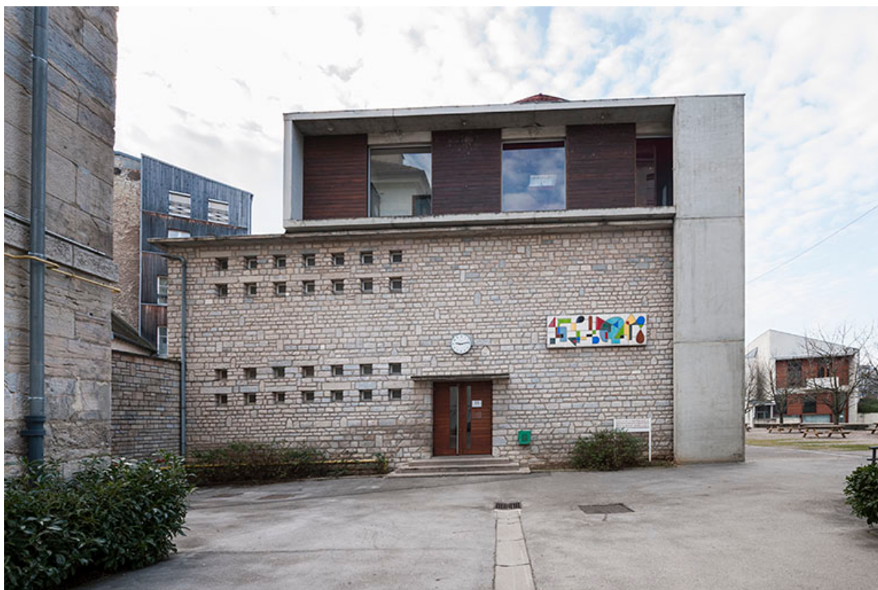
Le pignon nord de l'externat.
