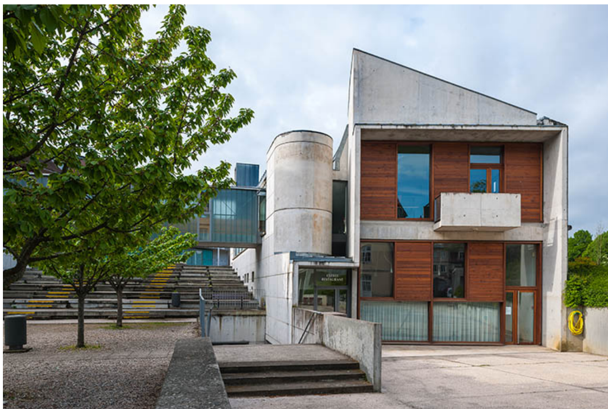
Pignon nord du restaurant d'application.
