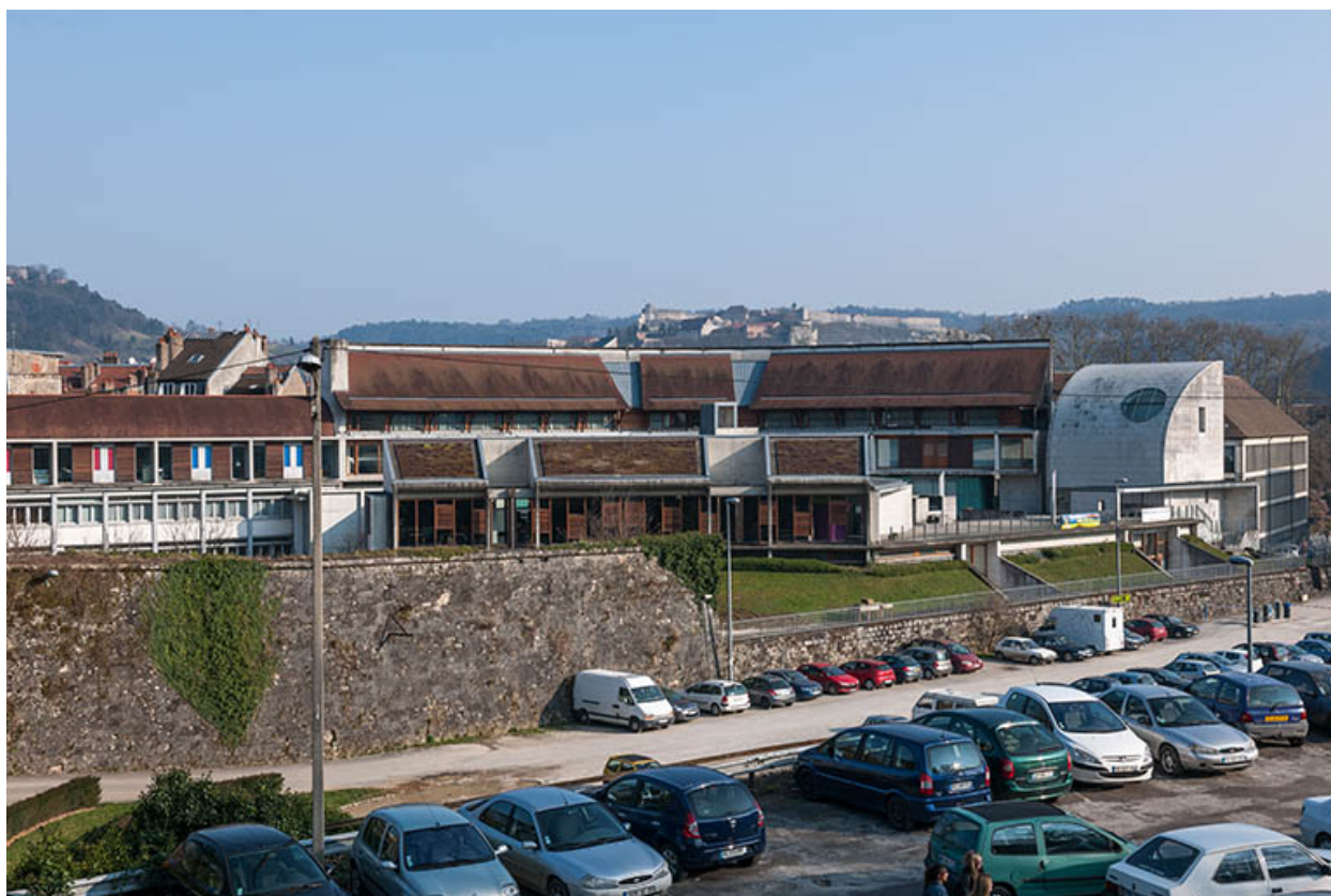
Vue d'ensemble des parties sud depuis l'ouest.
