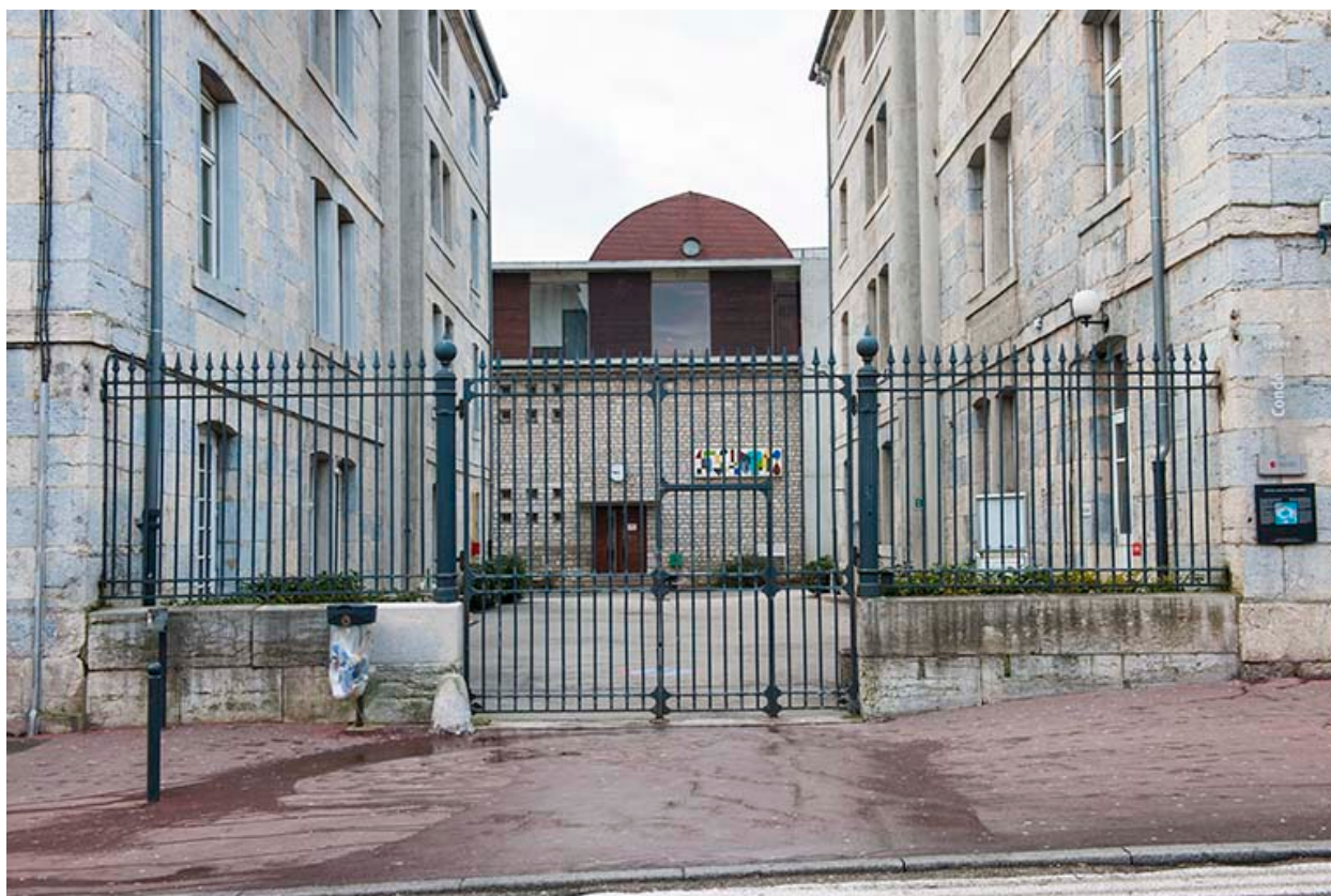
Grille d'entrée donnant sur la place.
