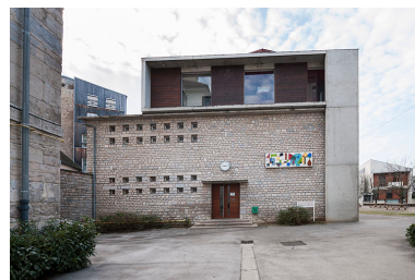
Le pignon nord de l'externat.
