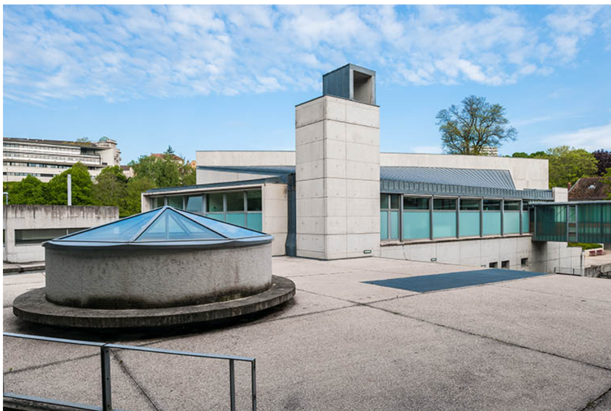
Angle sud-est du restaurant d'application.
