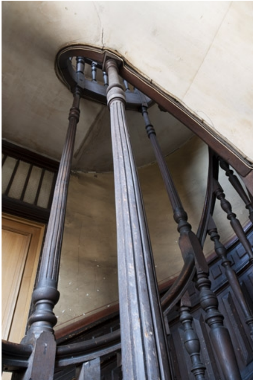
Détail des montants de l'escalier.
