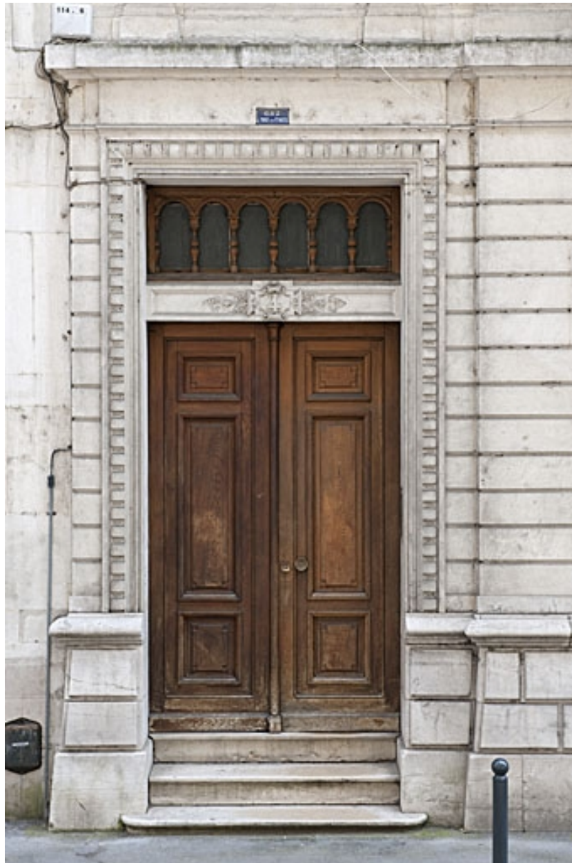
Façade antérieure : détail de la porte d'entrée.
