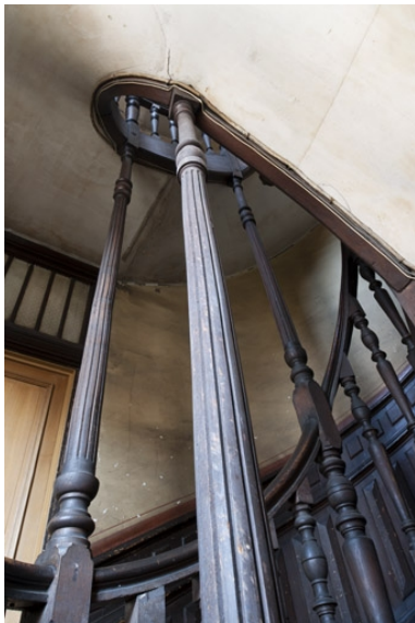
Détail des montants de l'escalier. Phot. Jérôme Mongreville IVR43_20112500027NUC4A
