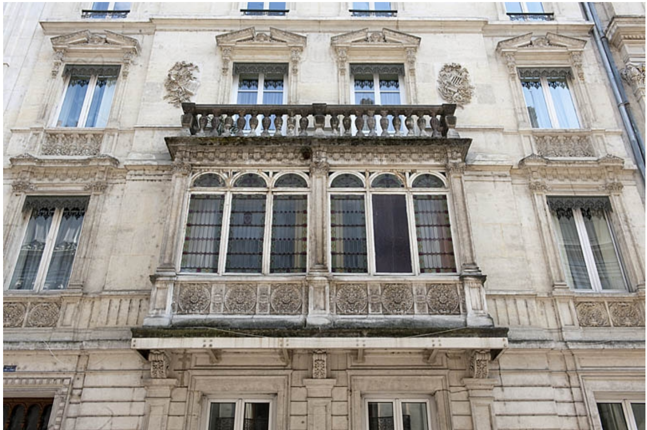
Façade antérieure : détail du bow-window de face.
