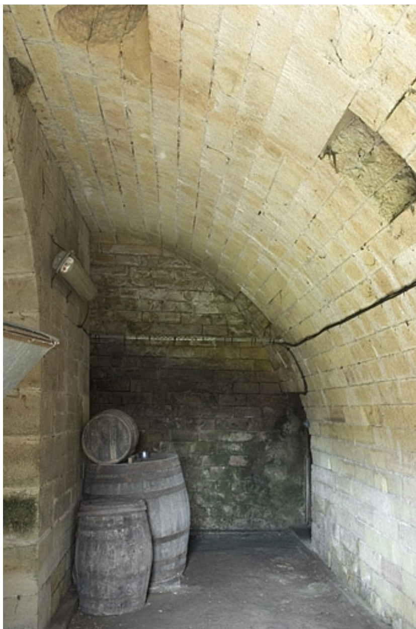
Couloir de circulation voûté d'un demi-berceau.
