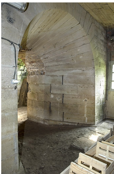
Détail d'une embrasure et de son appareillage. Phot. Jérôme Mongreville IVR43_20067000277NUCA
