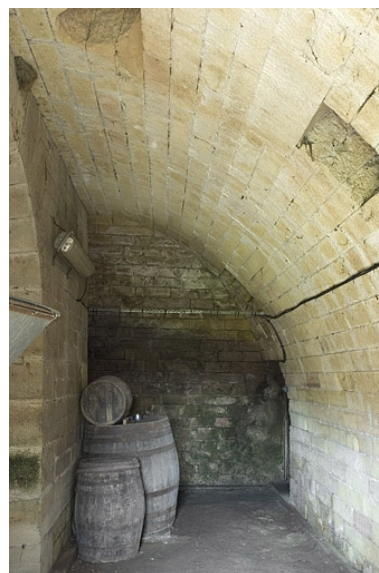
Couloir de circulation voûté d'un demi-berceau. Phot. Jérôme Mongreville IVR43_20067000279NUCA
