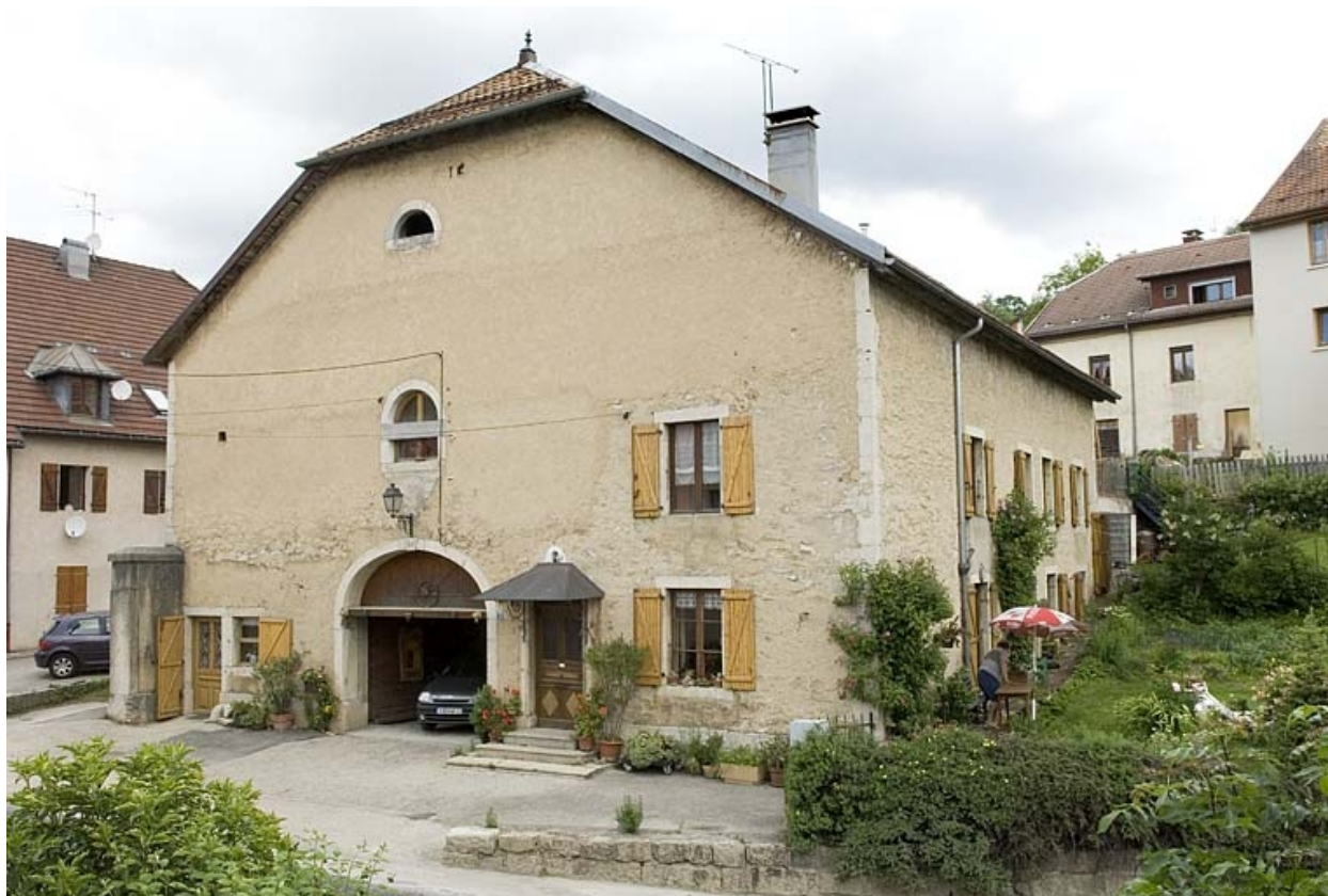
Façade antérieure, route des Alpes.
