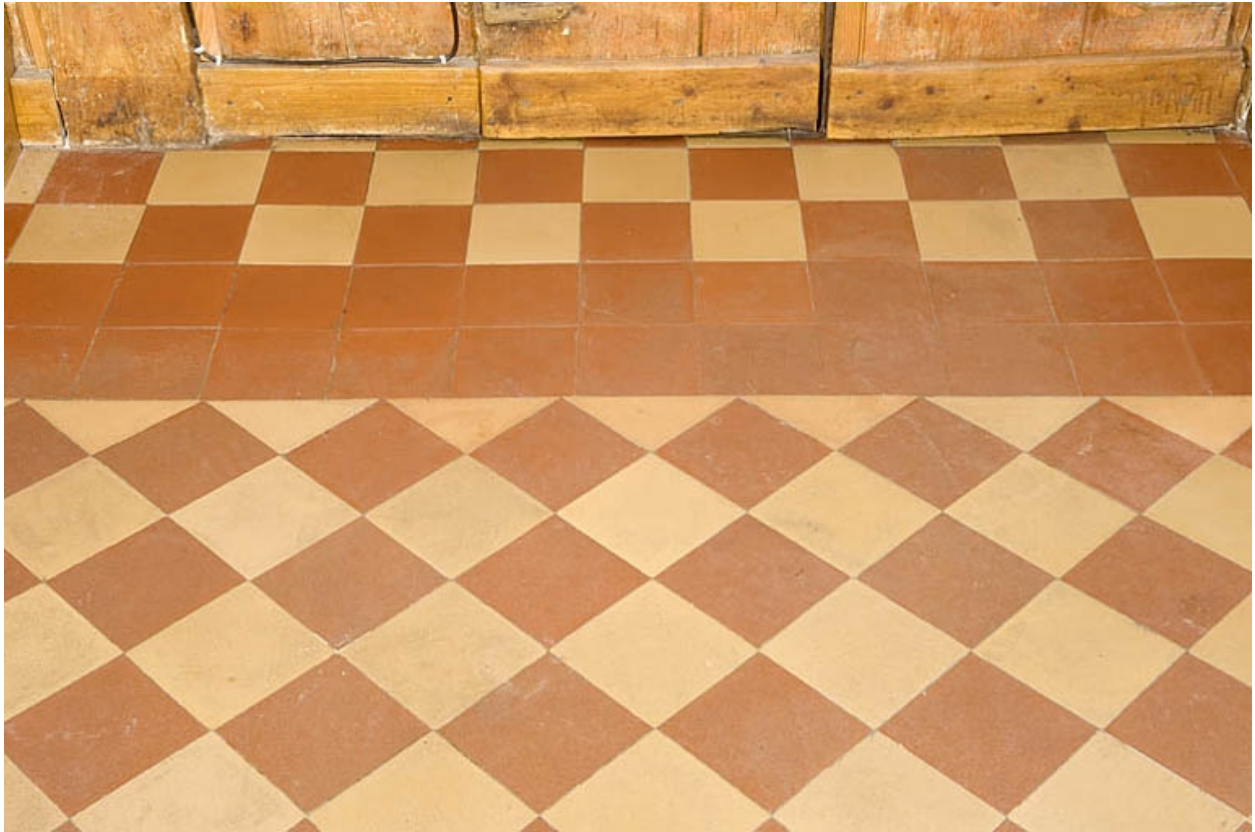
Cuisine du rez-de-chaussée : carreaux au sol.
