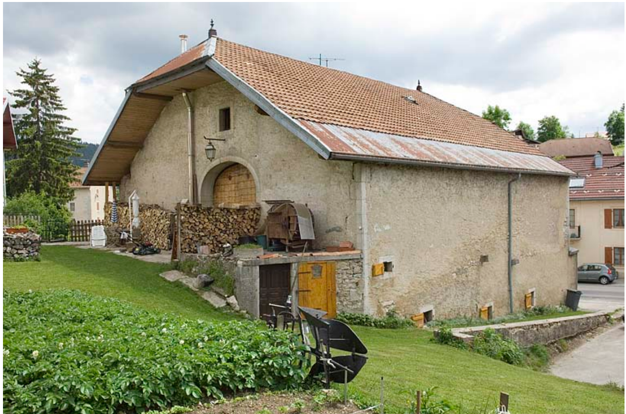
Façade postérieure et façade latérale gauche.
