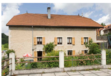
Façade latérale droite. Phot. Jérôme Mongreville IVR43_20092500788NUC2A
