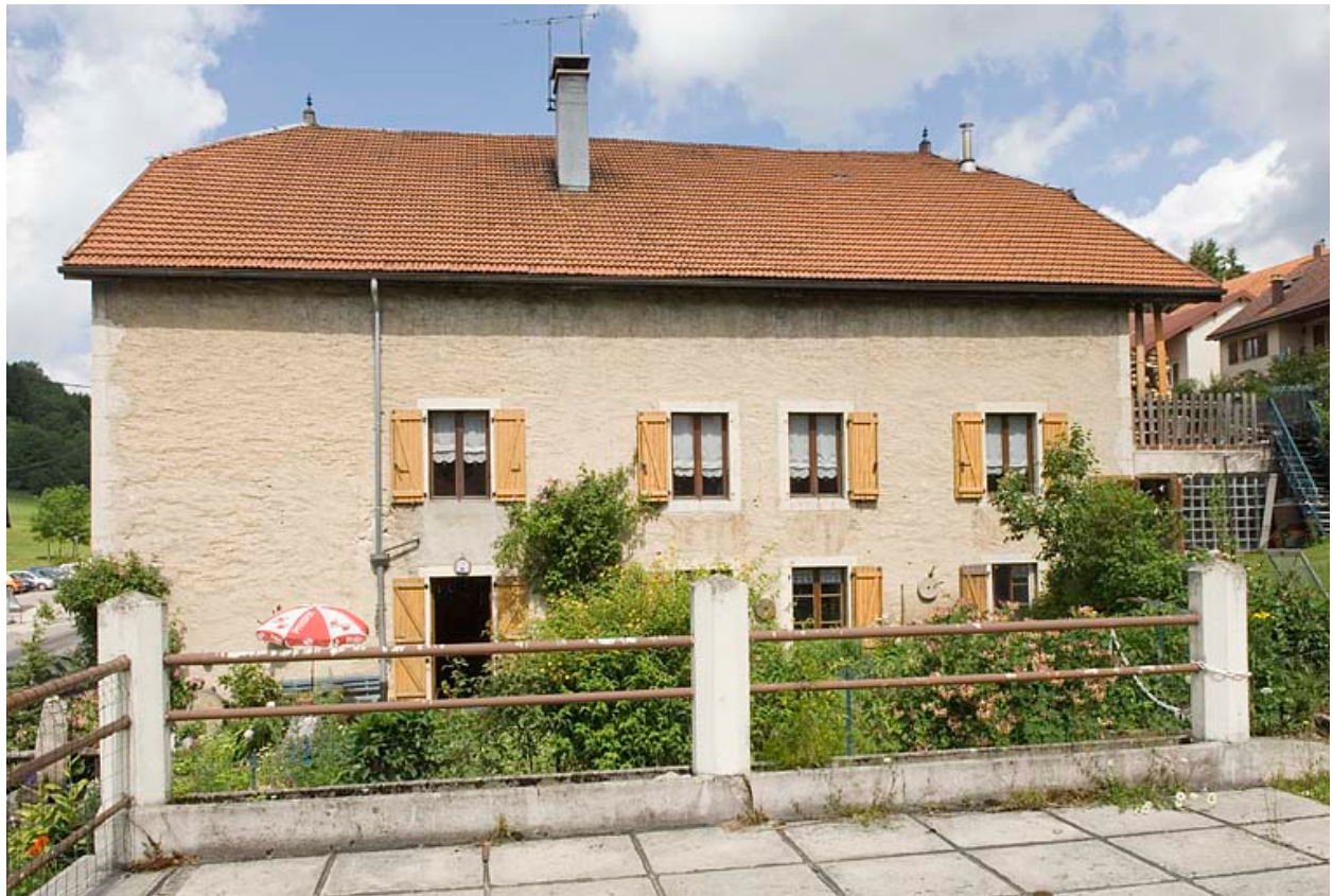
Façade latérale droite.
