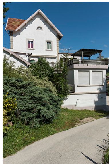
Usine : façade latérale droite. Phot. Sonia Dourlot IVR43_20172501059NUC4A
