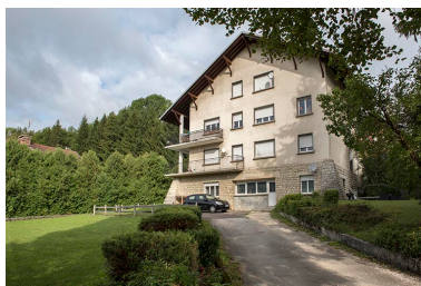
Maison : façade postérieure, de trois quarts droite. Phot. Sonia Dourlot IVR43_20172501062NUC4A
