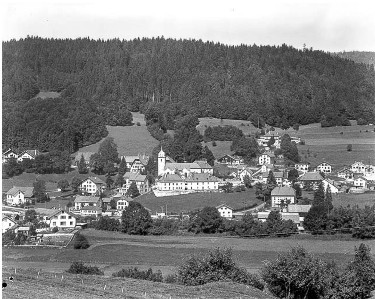
Vue d'ensemble du village en 1976, depuis l'est (Morestans).
