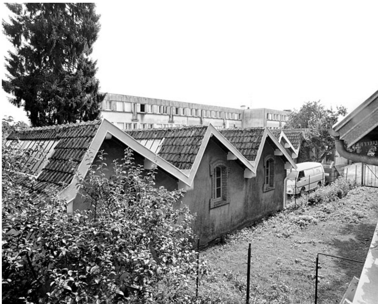
L'atelier de fabrication depuis le nord.
