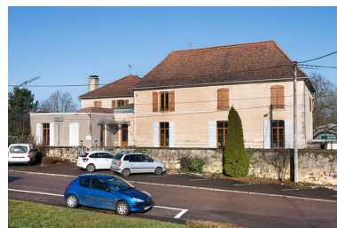
L'ancien orphelinat. Phot. Jérôme Mongreville IVR43_20177000097NUC4A
