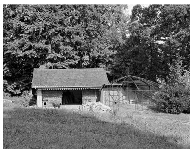
Bûcher et chenil en 1981.SRI. Enquête régionale sur les bâtiments industriels (1979-1981). Phot. Yves Sancey IVR43_19819000066X
