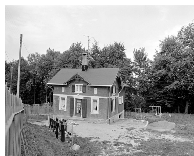
Conciergerie en 1981.SRI. Enquête régionale sur les bâtiments industriels (1979-1981). Phot. Yves Sancey IVR43_19819000065X
