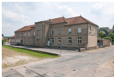
Façade postérieure. Phot. Jérôme Mongreville IVR43_20102501088NUC4A
