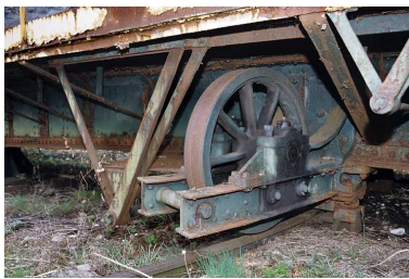
Roue et chemin de roulement. Phot. Yves Sancey IVR43_20053900789ZA
