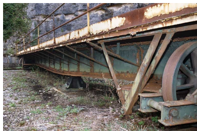
Tablier vu en enfilade. Phot. Yves Sancey IVR43_20053900791ZA
