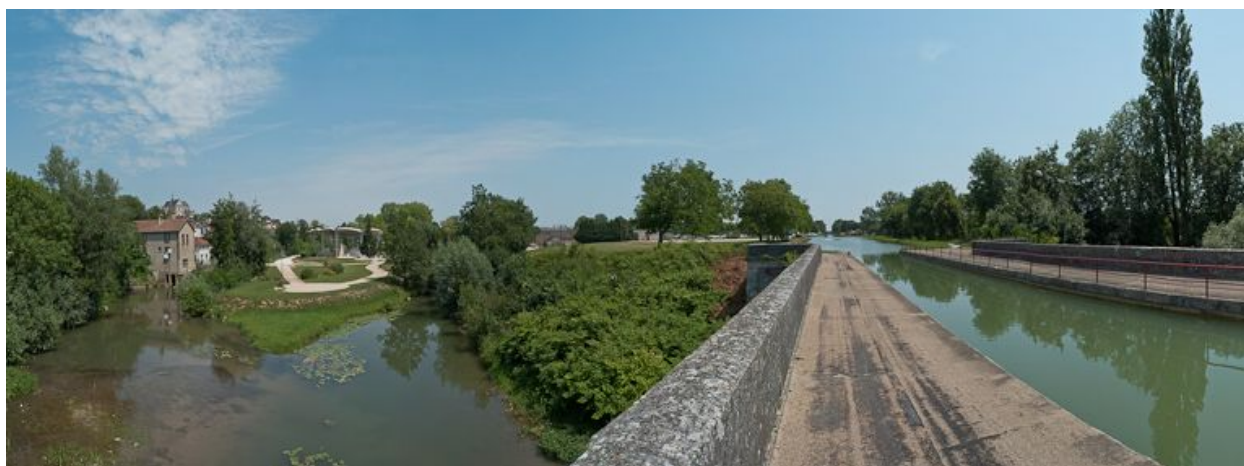
Vue du pont-canal et du paysage environnant.
