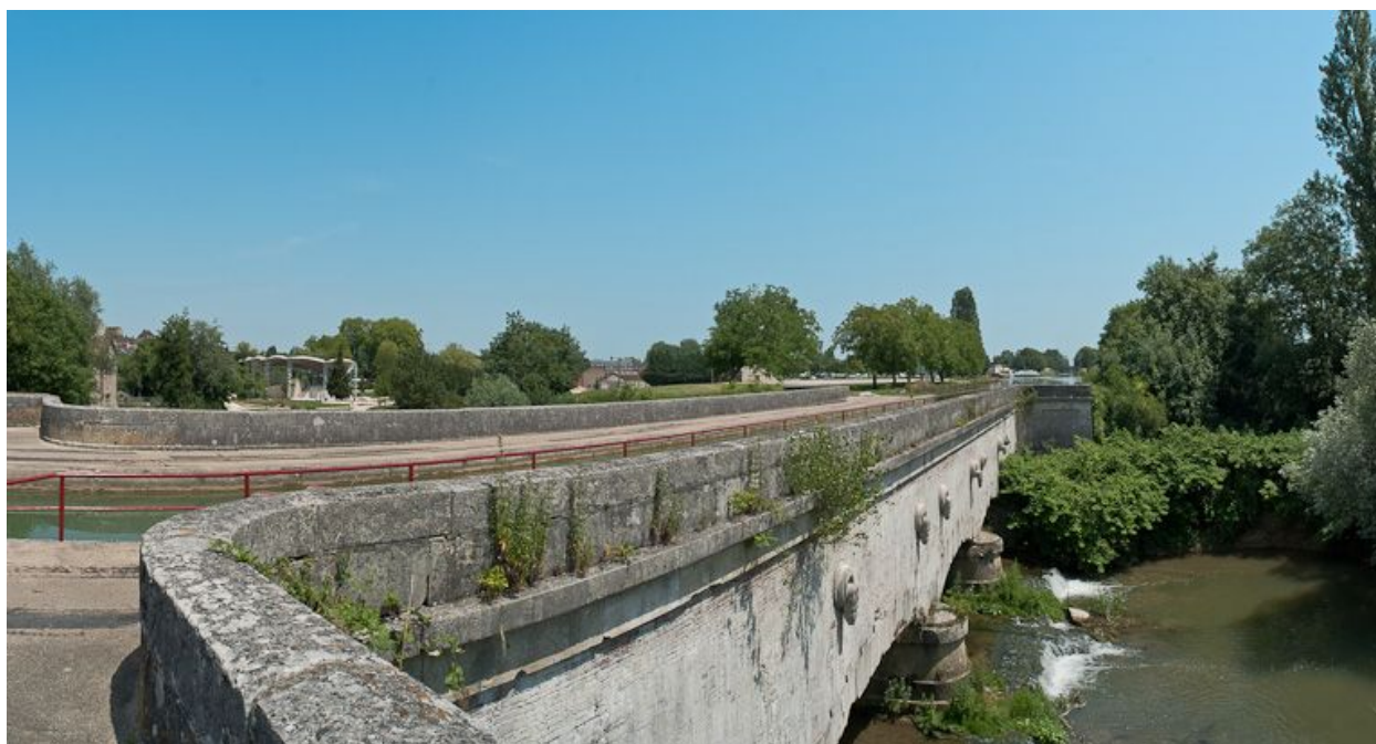
Vue du pont-canal.
