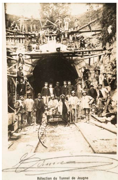
Réfection du tunnel de Jougne, 1909. Phot. Jérôme Mongreville IVR43_20102501523NUC4A
