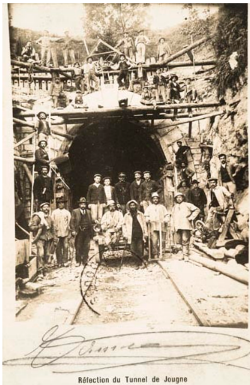
Réfection du tunnel de Jougne, 1909.
