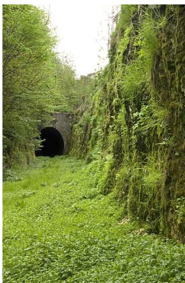
Tunnel et tranchée. Phot. Jérôme Mongreville IVR43_20092500491NUC2A
