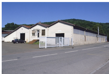
L'atelier de fabrication primitif. Phot. Jérôme Mongreville IVR43_20029000172ZA
