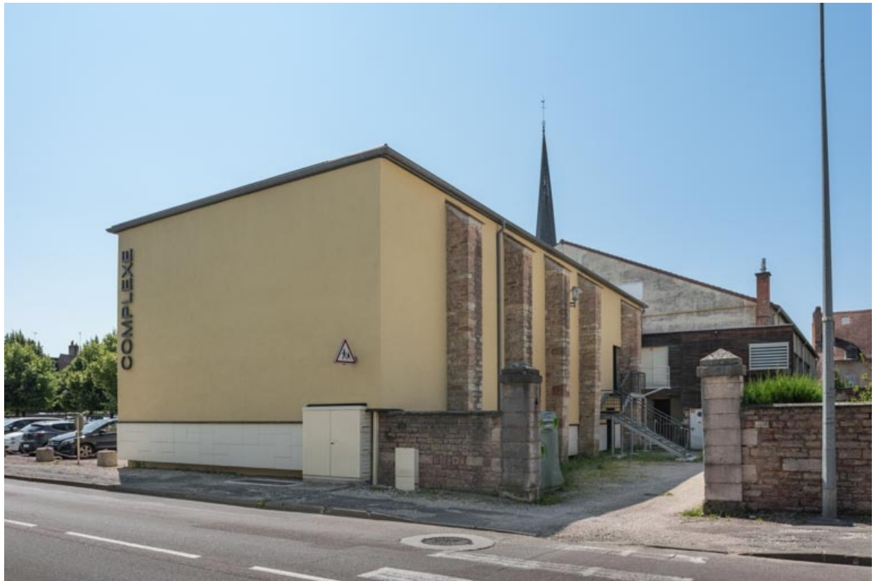
Façades postérieure et latérale droite.
