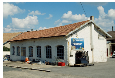
Premier bâtiment, vu de trois quarts droit. Phot. Laurent Poupard IVR43_19903900446ZA
