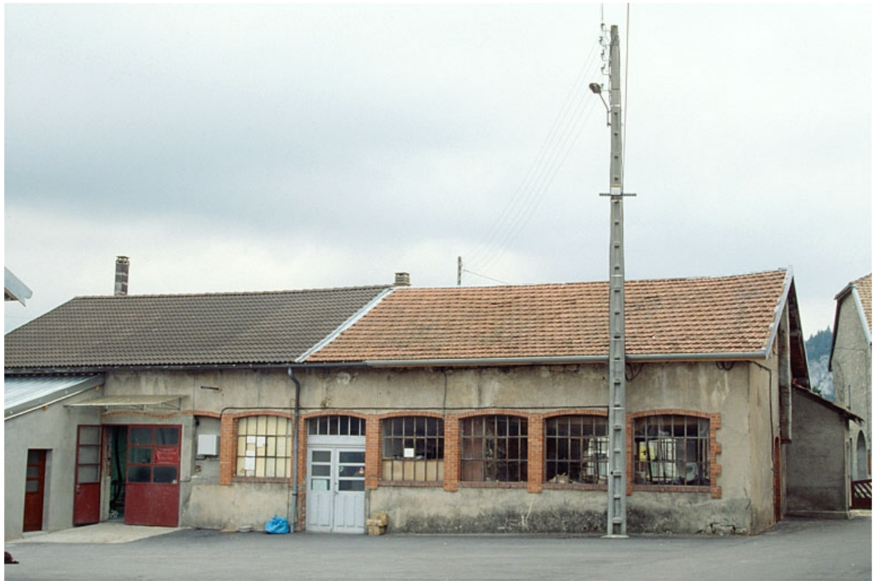
Façade antérieure du second bâtiment.
