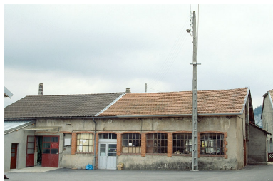
Façade antérieure du second bâtiment. Phot. Laurent Poupard IVR43_19903900447ZA
