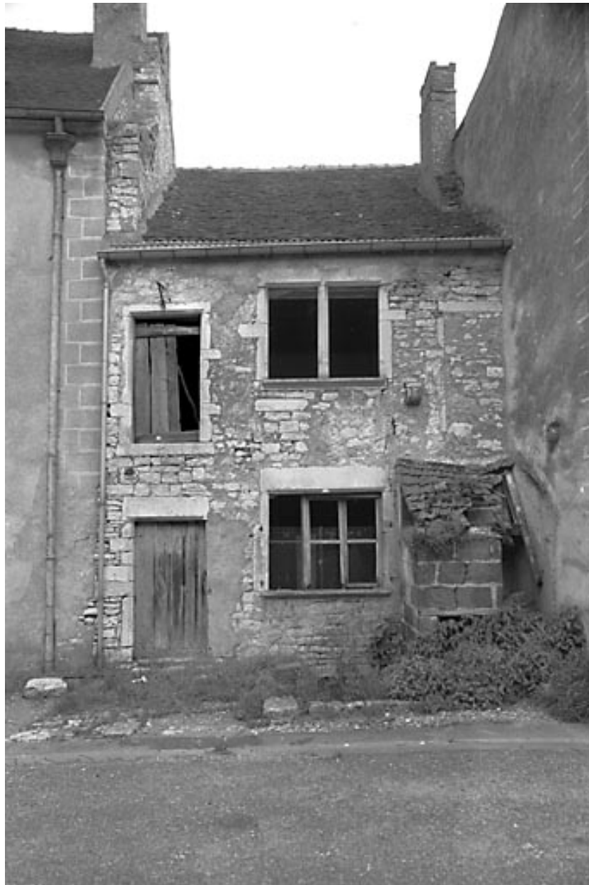
Maison située rue Gollu : façade antérieure.
