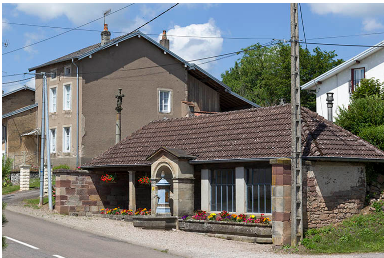
Vue d'ensemble depuis la Grande Rue.
