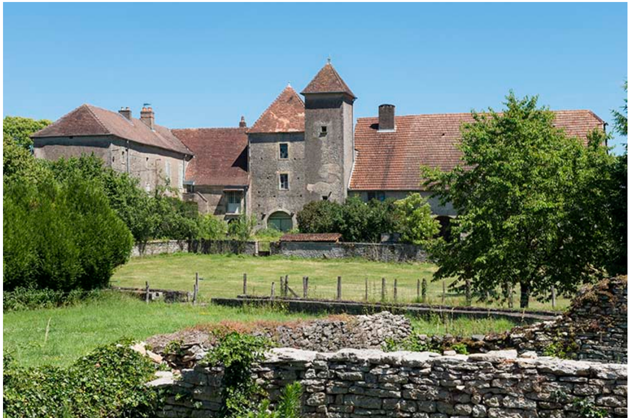
Vue d'ensemble de la maison forte.
