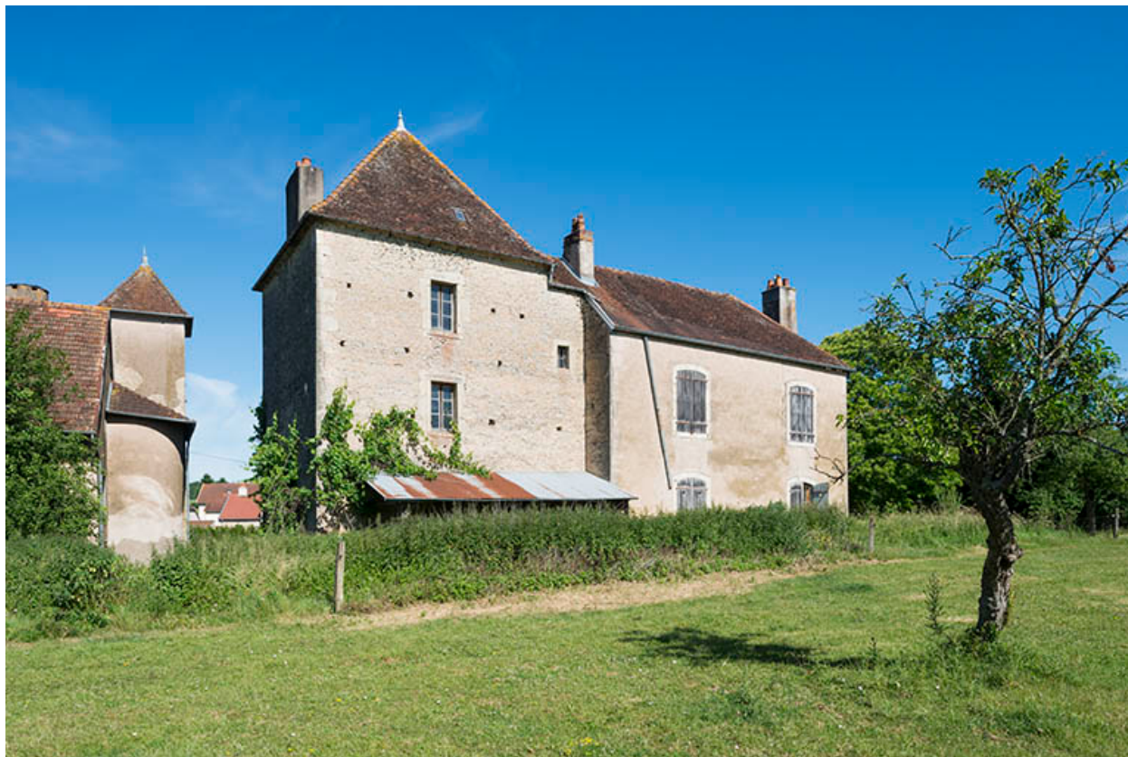
La façade postérieure du bâtiment XVIIIe.
