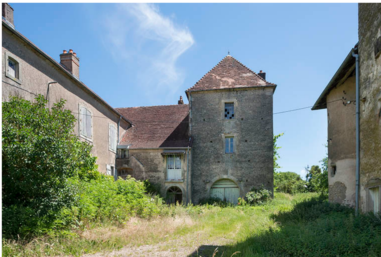
La cour intérieure de la maison forte.
