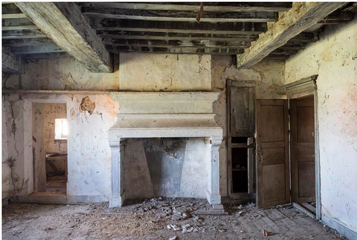
Cheminée de la chambre, logis 16e siècle.
