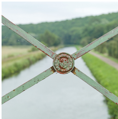
Détail du garde-corps.
