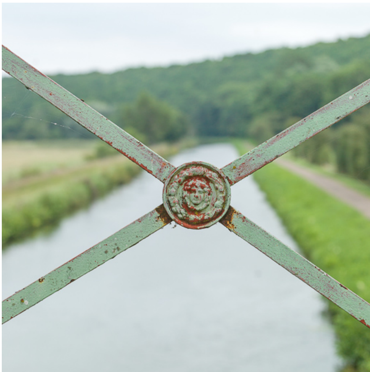
Détail du garde-corps.
