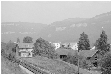
Vue d'ensemble depuis le sud. Phot. Laurent Poupard IVR43_19903900511Z
