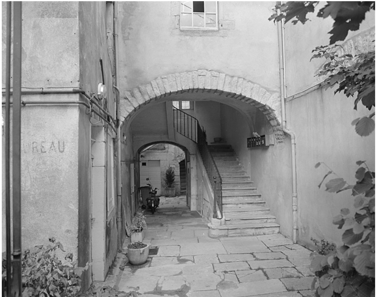
Escalier formant passage d'accès à la cour.
