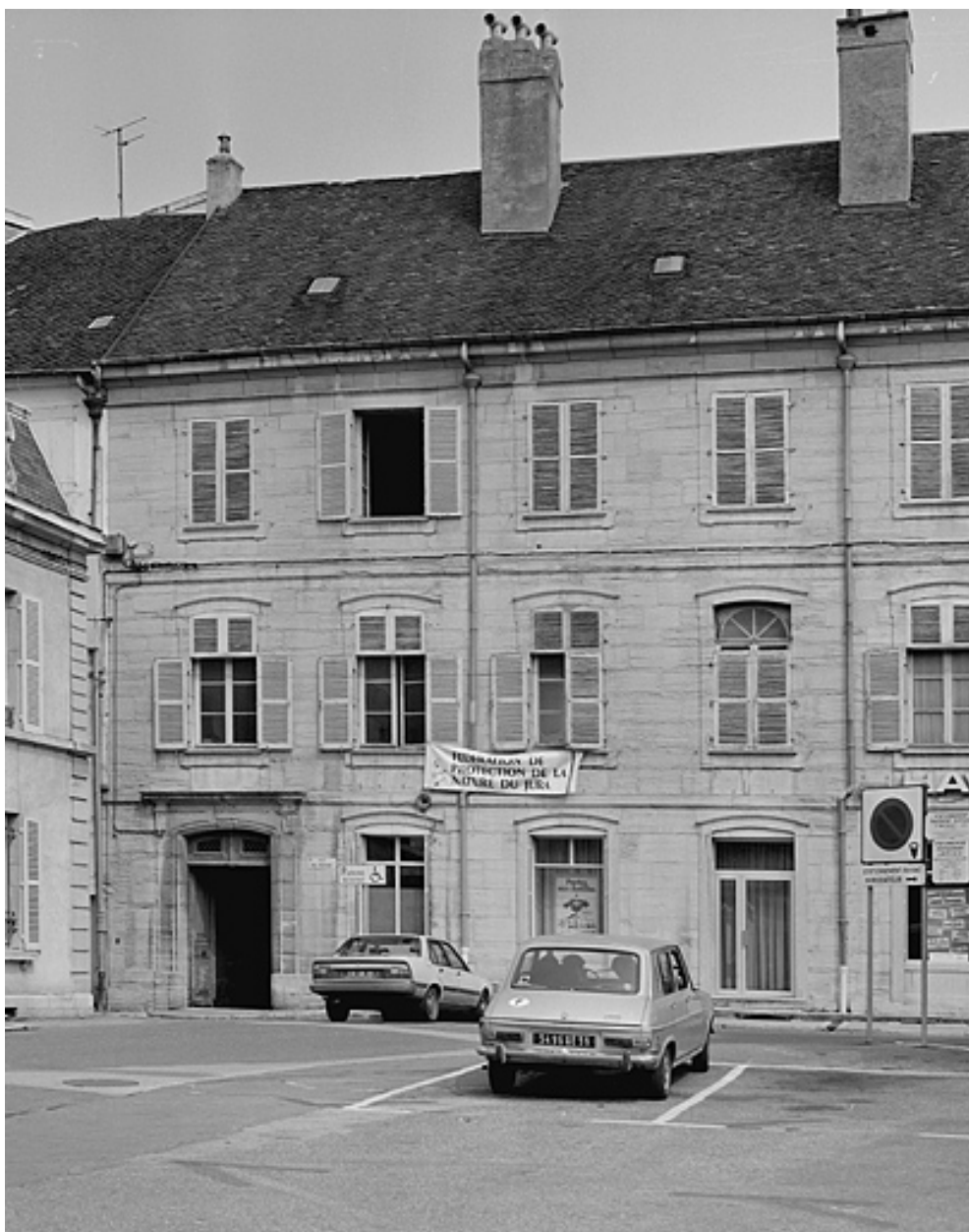
Façade antérieure, partie gauche.
