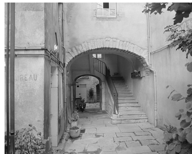
Escalier formant passage d'accès à la cour. Phot. Yves Sancey IVR43_19833900596X
