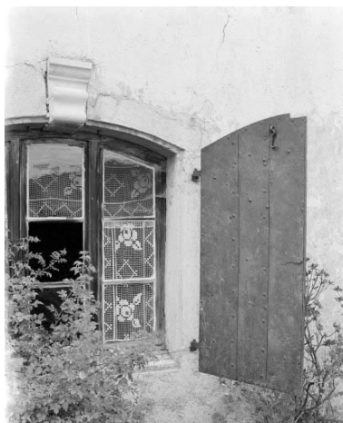
Fenêtre du "carré" : volet ouvert. Phot. Yves Sancey IVR43_19772500375X
