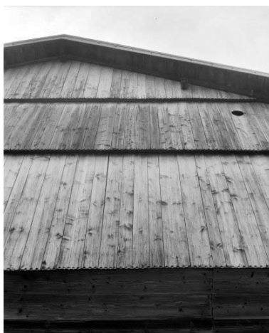
Lambrechure de la façade antérieure. Phot. Yves Sancey IVR43_19772500371X
