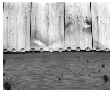
Détail : extrémité inférieure des planches de la lambrechure de la façade. Phot. Yves Sancey IVR43_19772500372X
