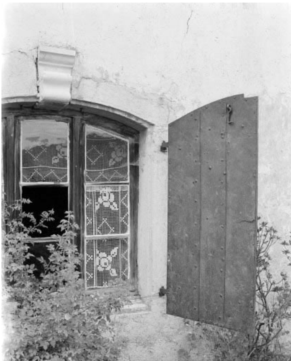
Fenêtre du "carré" : volet ouvert.
