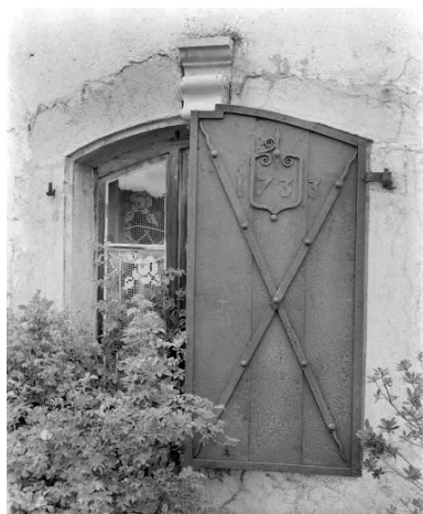
Fenêtre du "carré" : volet fermé. Phot. Yves Sancey IVR43_19772500374X
