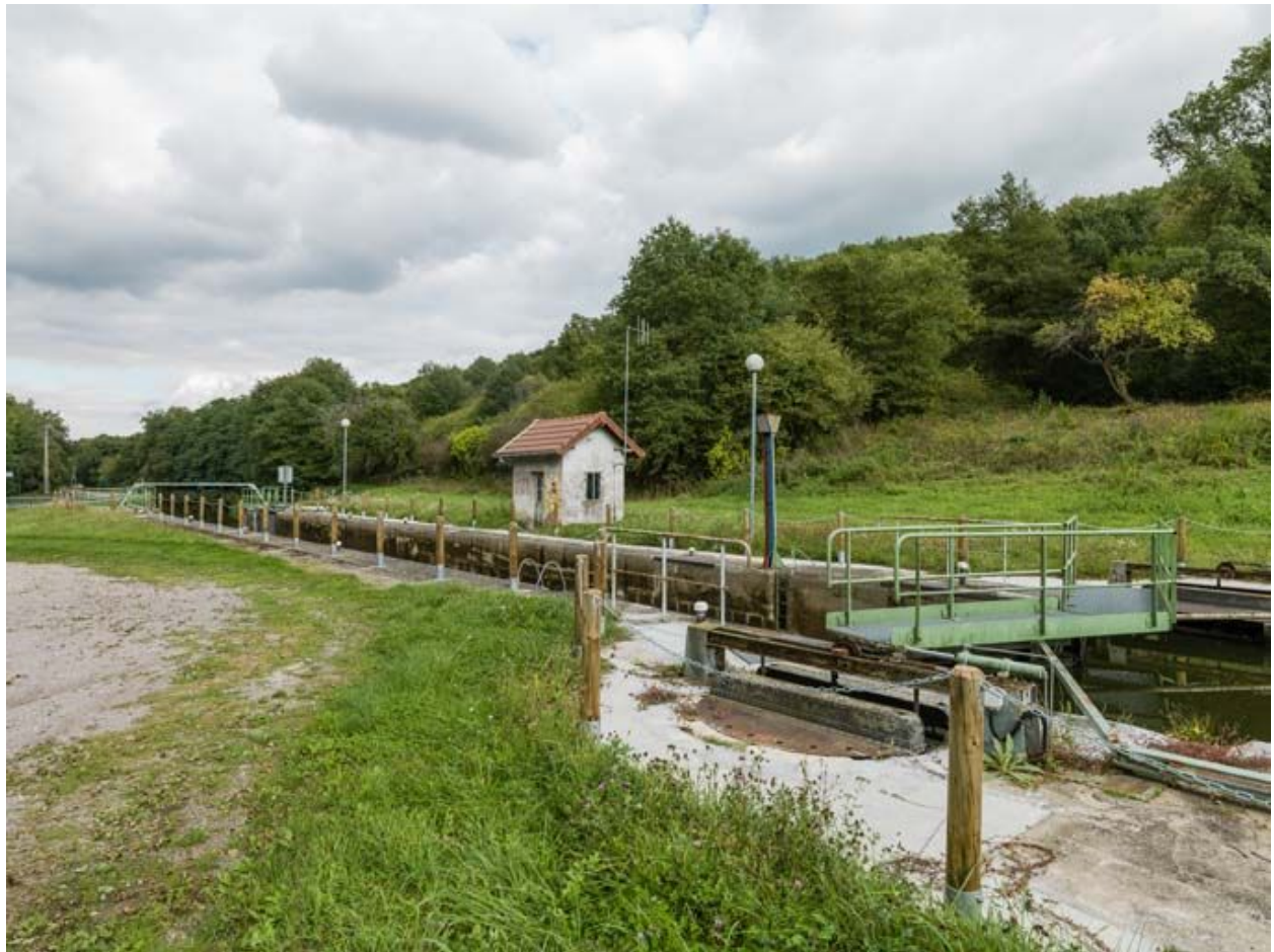
Vue d'ensemble du site d'écluse.
