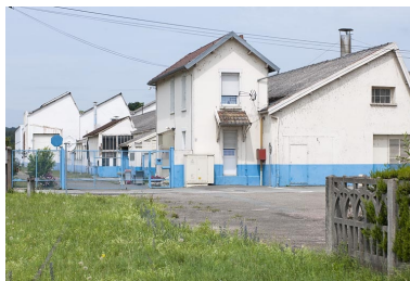
Bâtiments sud et conciergerie depuis le sud-est.
