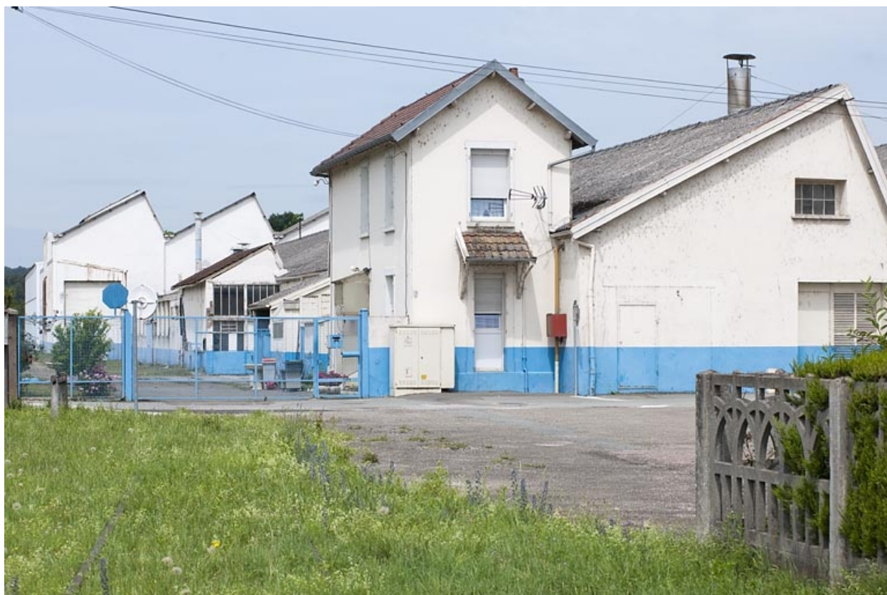
Bâtiments sud et conciergerie depuis le sud-est.
