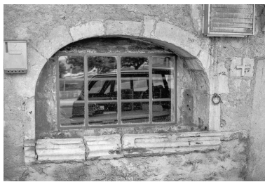
Fenêtre de l'écurie avec mangeoire. Phot. Gilbert Poinot IVR43_19752501466Z
