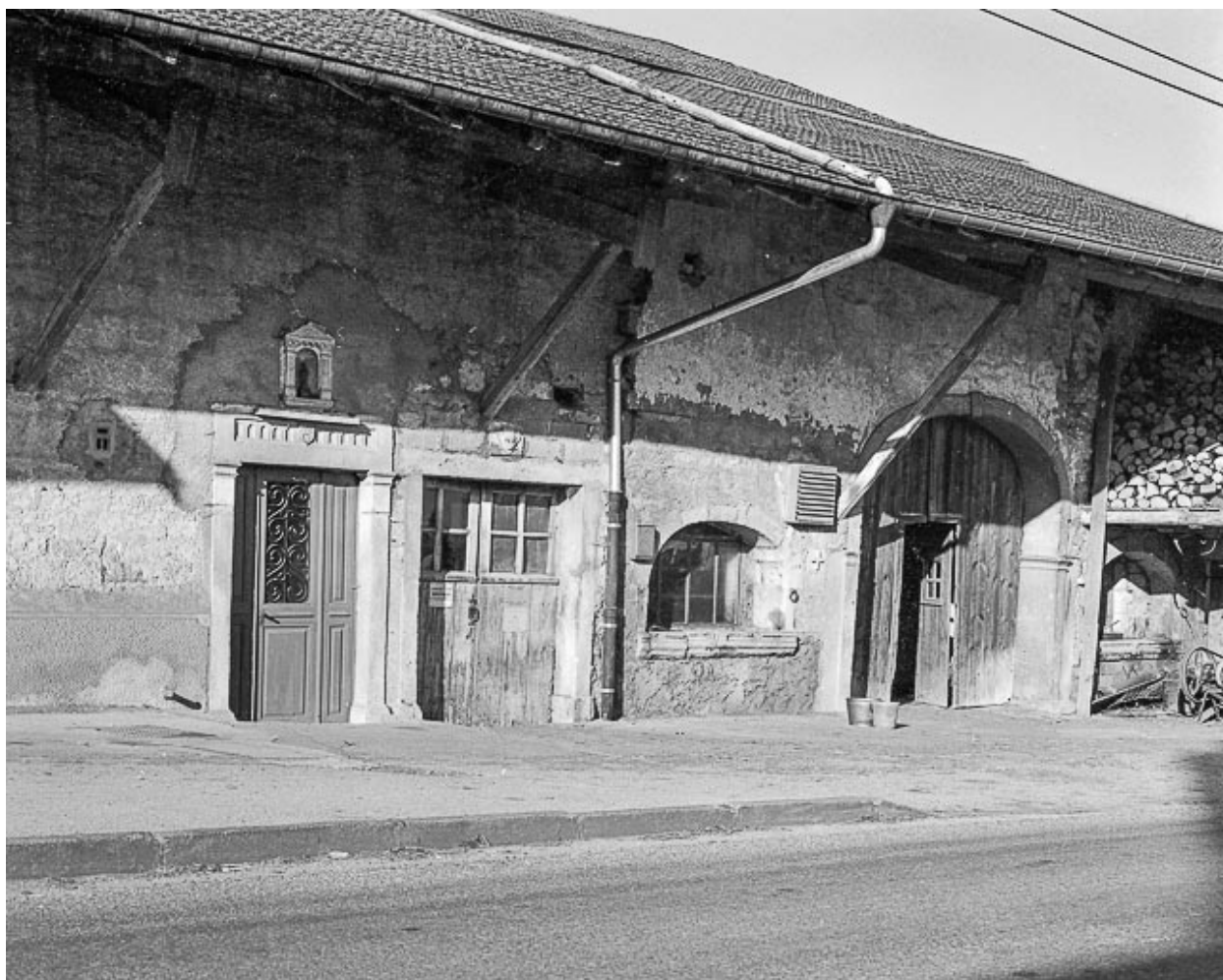
Détail de la façade sur rue.
