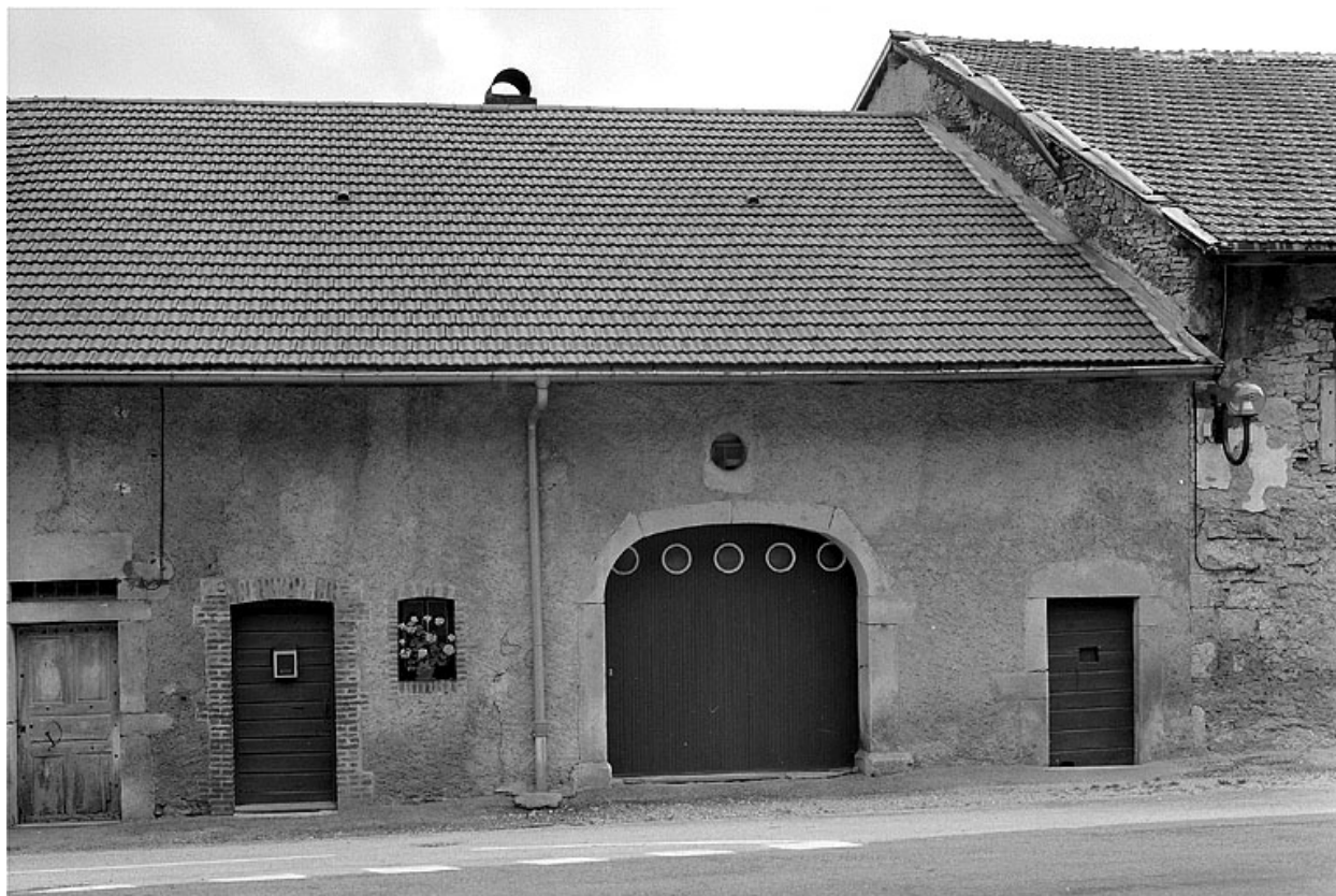
Façade sur la rue.
