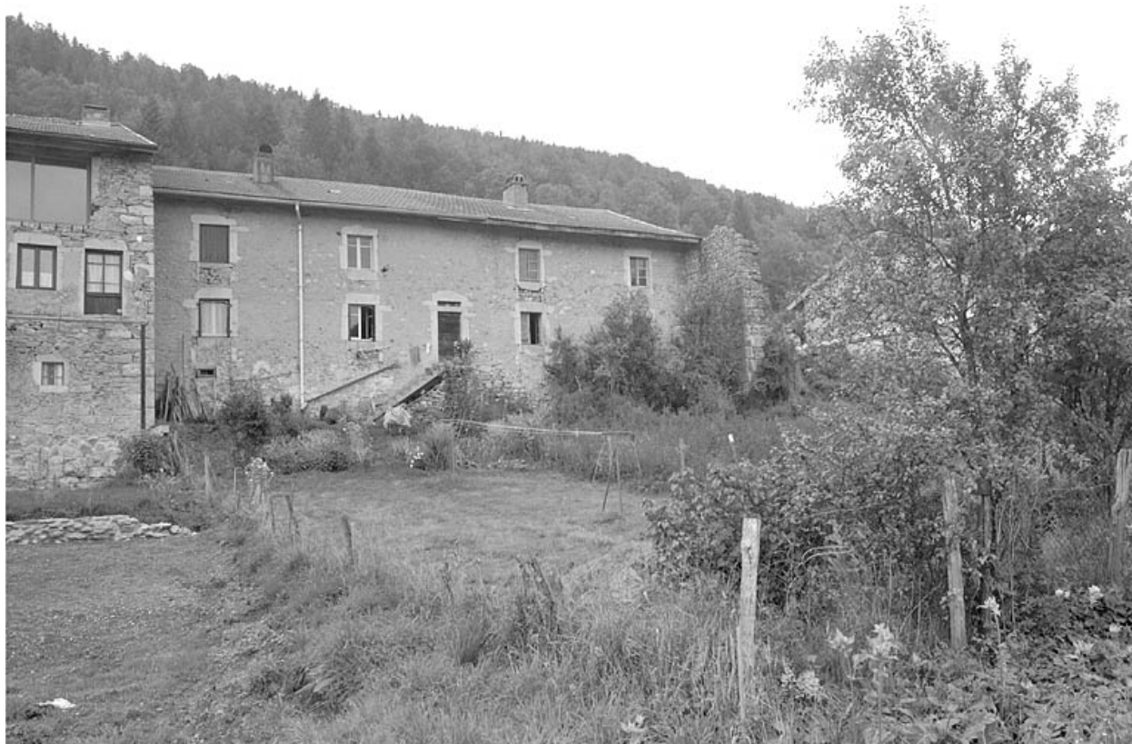
Façade postérieure, vue générale.
