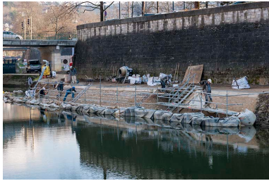
Réfection du perré du chemin de halage en aval du moulin Saint- Paul : vue d'ensemble depuis l'aval. Phot. Jérôme Mongreville IVR43_20152502360NUC4A
