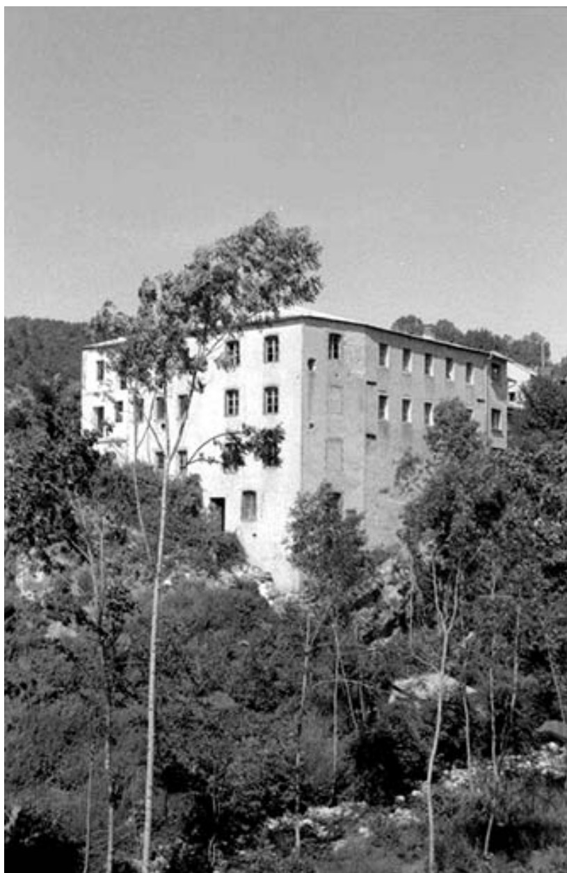
Partie ancienne (atelier de fabrication et bureau).
