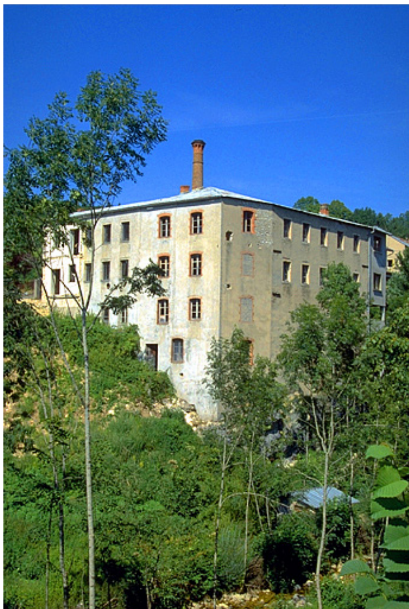
Partie ancienne (atelier de fabrication et bureau).
