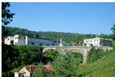
Vue d'ensemble depuis le sud. Phot. Laurent Poupard IVR43_19913901286ZA
