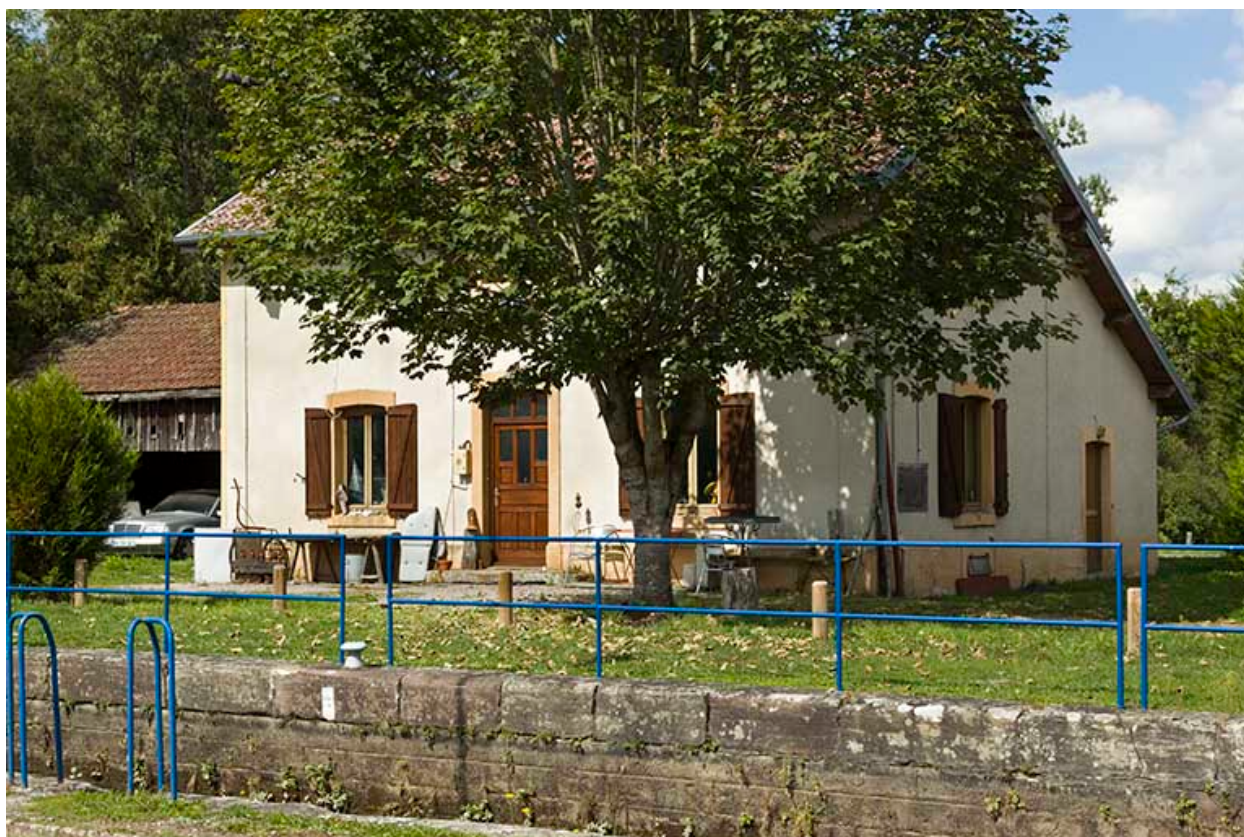
La maison d'éclusier, écluse n°39.
