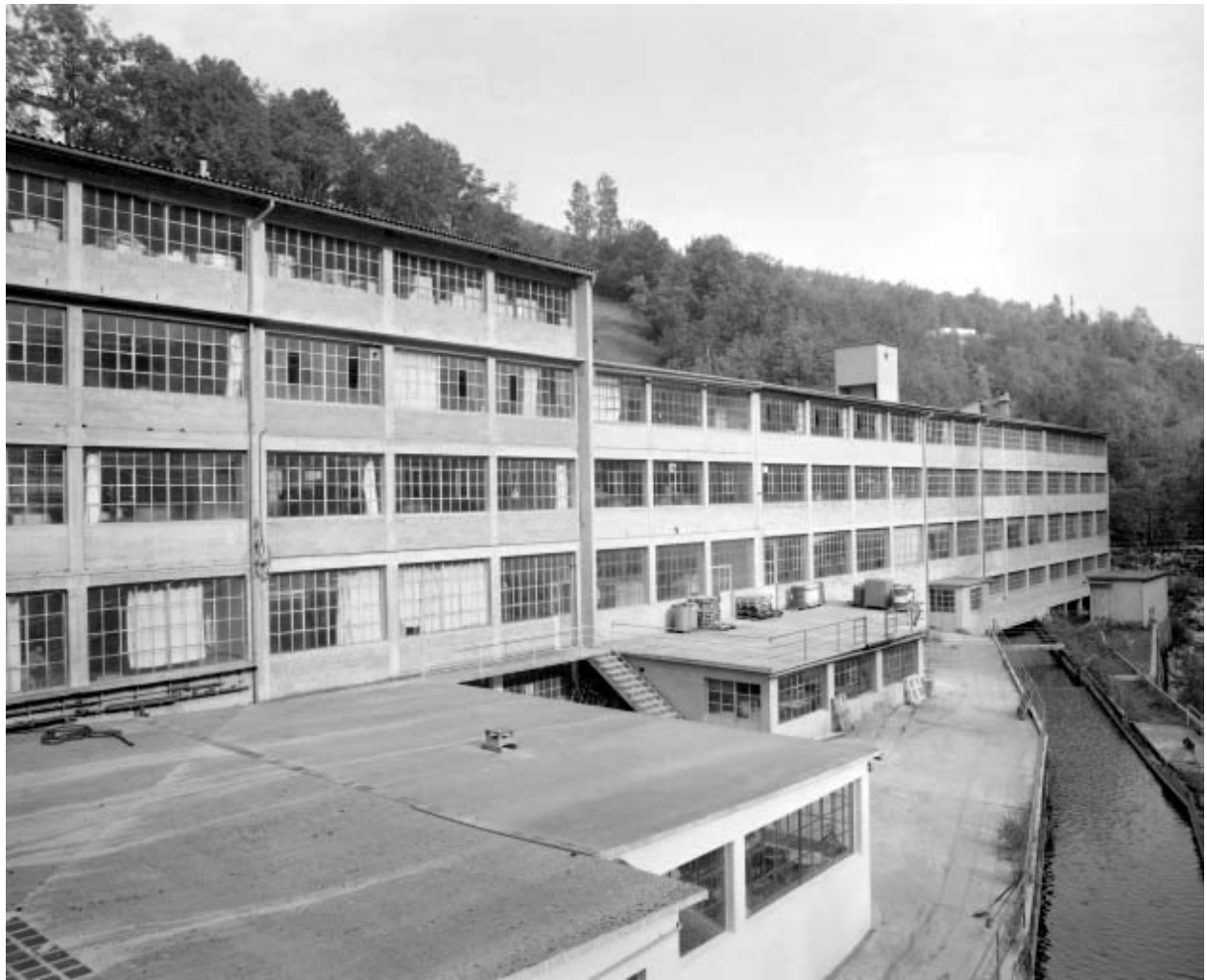
Façade postérieure des ateliers de fabrication.
