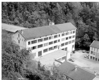
Entrepôt industriel, bureau et atelier de conditionnement. Phot. Jérôme Mongreville IVR43_19923900651X
