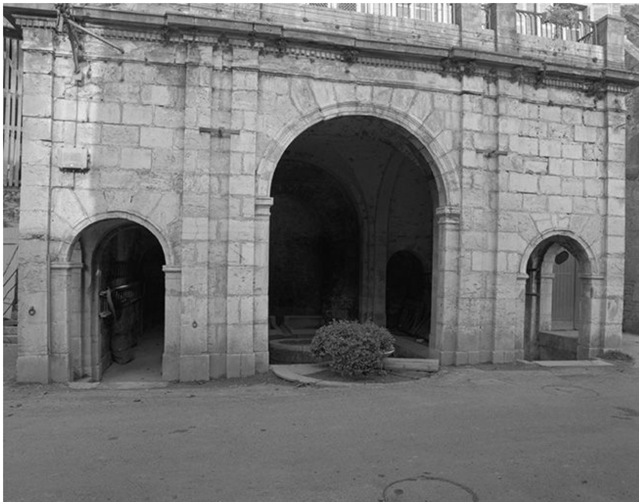
Façade antérieure : détail du rez-de-chaussée.
