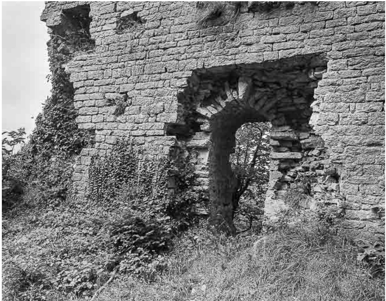
Vue extérieure du donjon : détail d'une porte.
