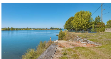
Rampe et perrés au port d'Ouroux.
