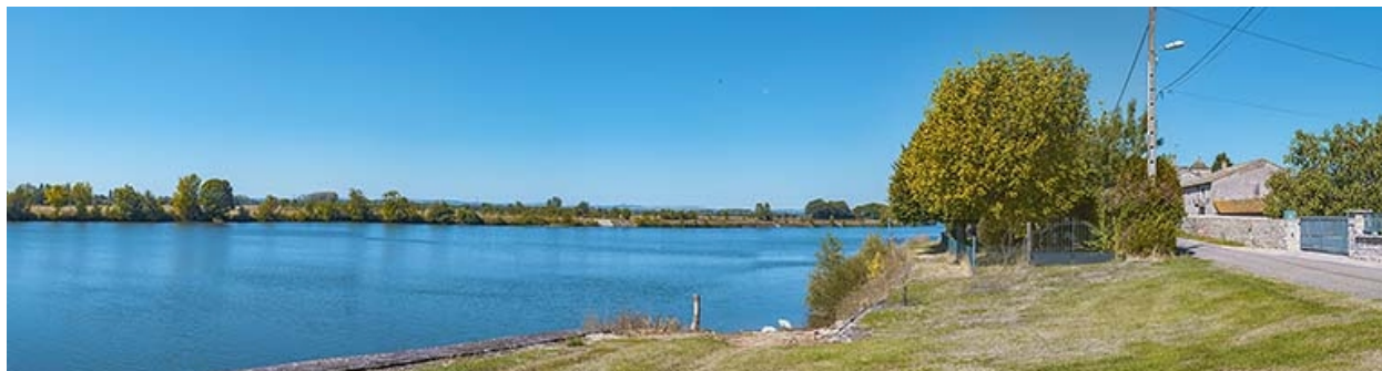
Rampe et perrés au port d'Ouroux.
