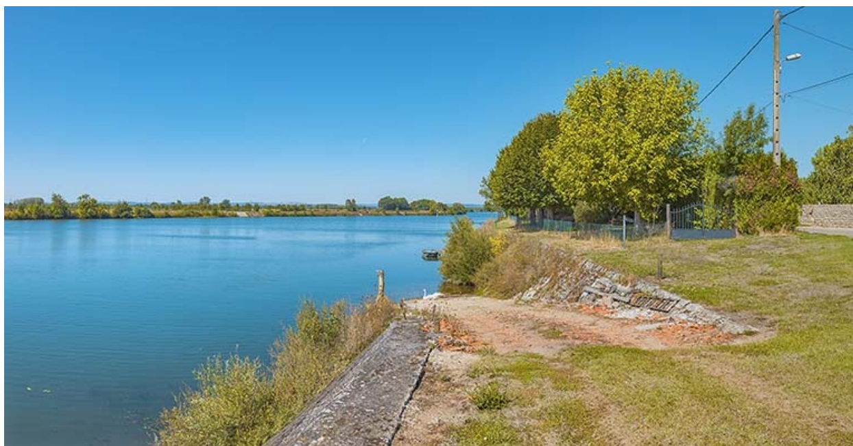
Rampe et perrés au port d'Ouroux.
