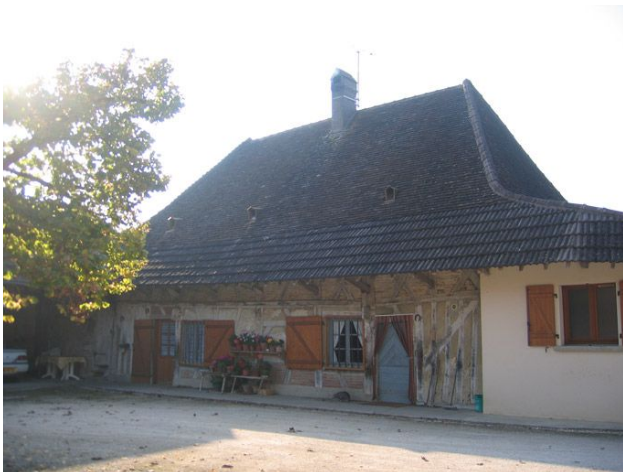
Vue d'ensemble de la façade de l'habitation.
