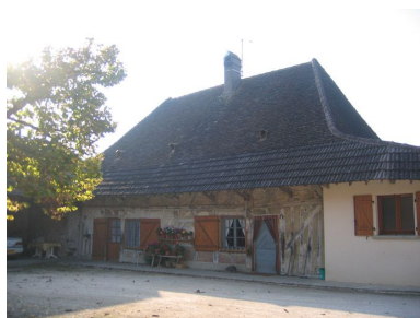
Vue d'ensemble de la façade de l'habitation.
