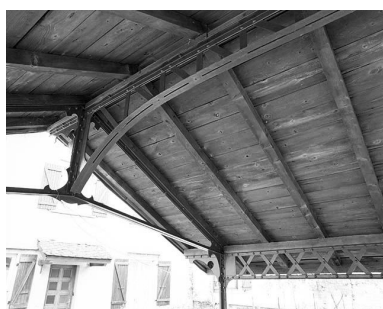
Charpente métallique : faitage et sablière. Phot. Yves Sancey IVR43_19993900272X
