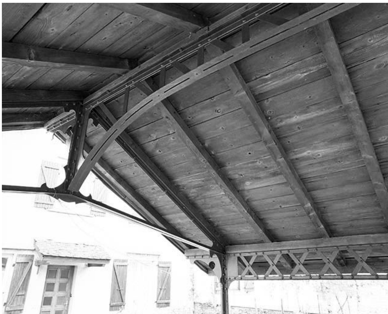
Charpente métallique : faîtage et sablière.
