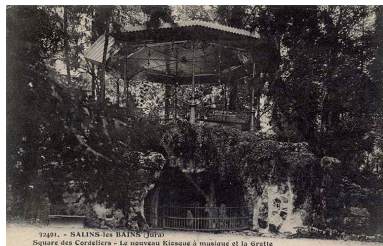
Vue ancienne. Autr. auteur inconnu IVR43_20223900797NUC4A
